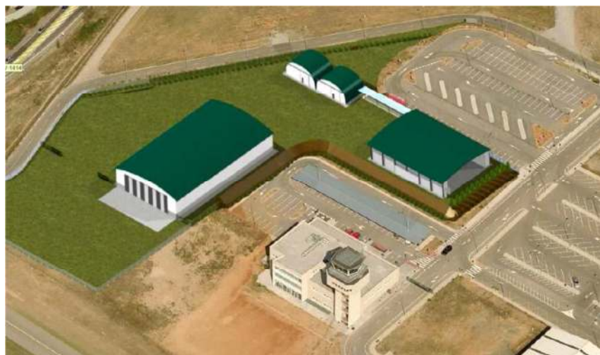
HANGARS – MUSEU AEROPORT DE SABADELL (Vallès Occ.).- Situació i projecte de construcció del futur Museu de l'Aeroport de Sabadell.
