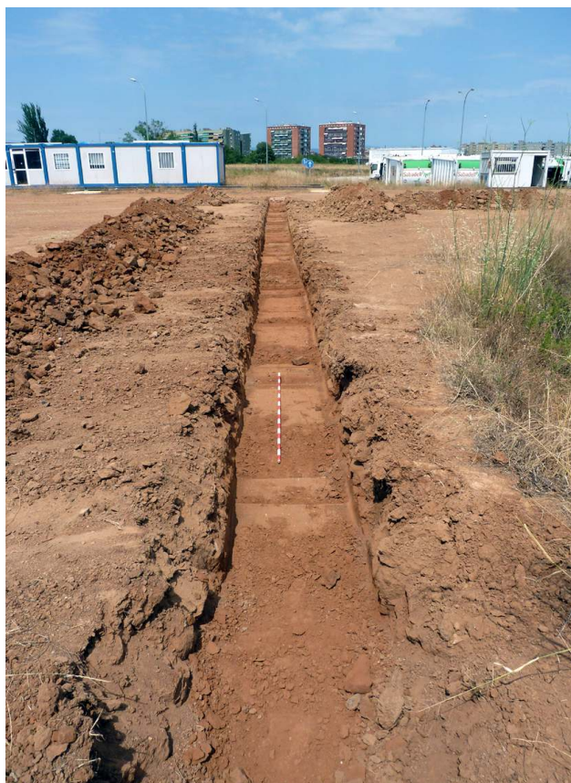
HANGARS – MUSEU AEROPORT DE SABADELL (Vallès Occ.). - Vista de la Rasa 4 excavada en el sector Jardí-Museu Aeronàutic . Presenta una amplada d'1 m i una llargada de 45 m apareixent i una fondària d'uns 50cm, apareixent el terreny natural d'argiles vermelles quaternàries.
