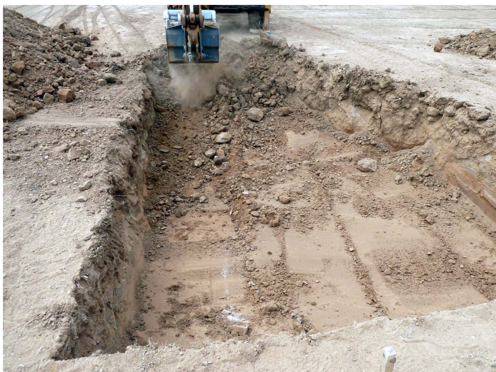
HANGARS – MUSEU AEROPORT DE SABADELL (Vallès Occ.) .- Vista de l'excavació de la Rasa 1 amb màquina retroexcavadora amb pala plana. Es pot observar que per sota del nivell superficial apareix el terreny natural d'argiles plàstiques sense presència de restes ni material arqueològic de cap tipus.
