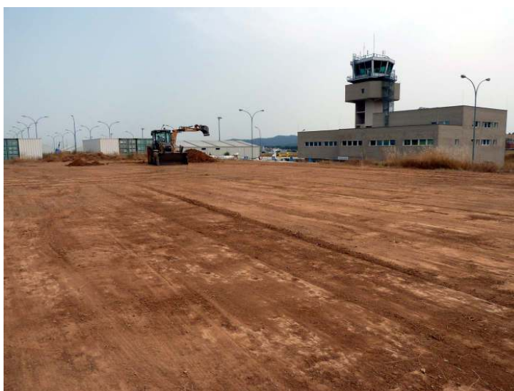
HANGARS – MUSEU AEROPORT DE SABADELL (Vallès Occ.).- Vistes generals de l'emplaçament de les tres zones d'actuació: Hangar-Garatge, Pavelló Obert, i Jardí Museu Aeronàutic. Al fons s'hi observa l'excavació de la Rasa 1 i l'edifici de la torre de control.
