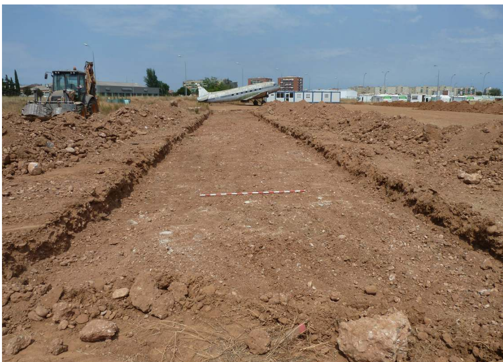
HANGARS – MUSEU AEROPORT DE SABADELL (Vallès Occ.). - Vista de la Rasa 2 de 4’5 m d’amplada i 53 m de llargada, feta amb una direcció N-S. No es va documentar cap tipus de resta arqueològica.
