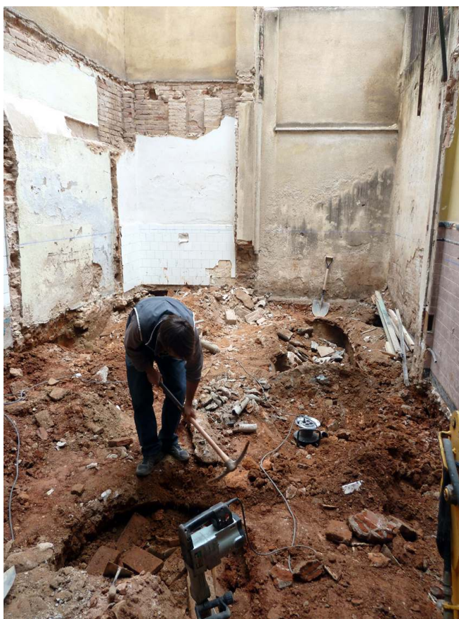
C/ SANT FELIU, 9 (Sabadell, Vallès Occ.).- Vista dels treballs de control de l'enderroc i rebaix del subsòl a la part posterior corresponent al pati.
