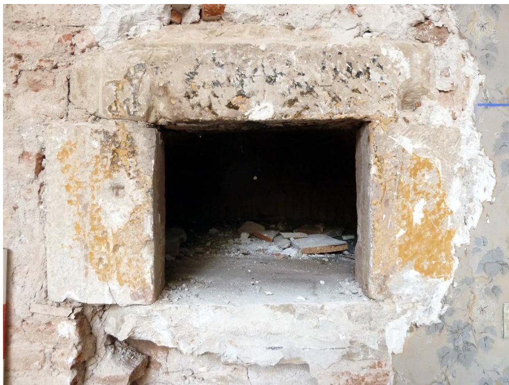
C/ SANT FELIU, 9 (Sabadell, Vallès Occ.).- Detall de la boca del forn de pa, amb llinda i brancals de pedra encastats dins l'estructura del sota escala de rajols del casal, correspon a l'obra original del s. XIX.
