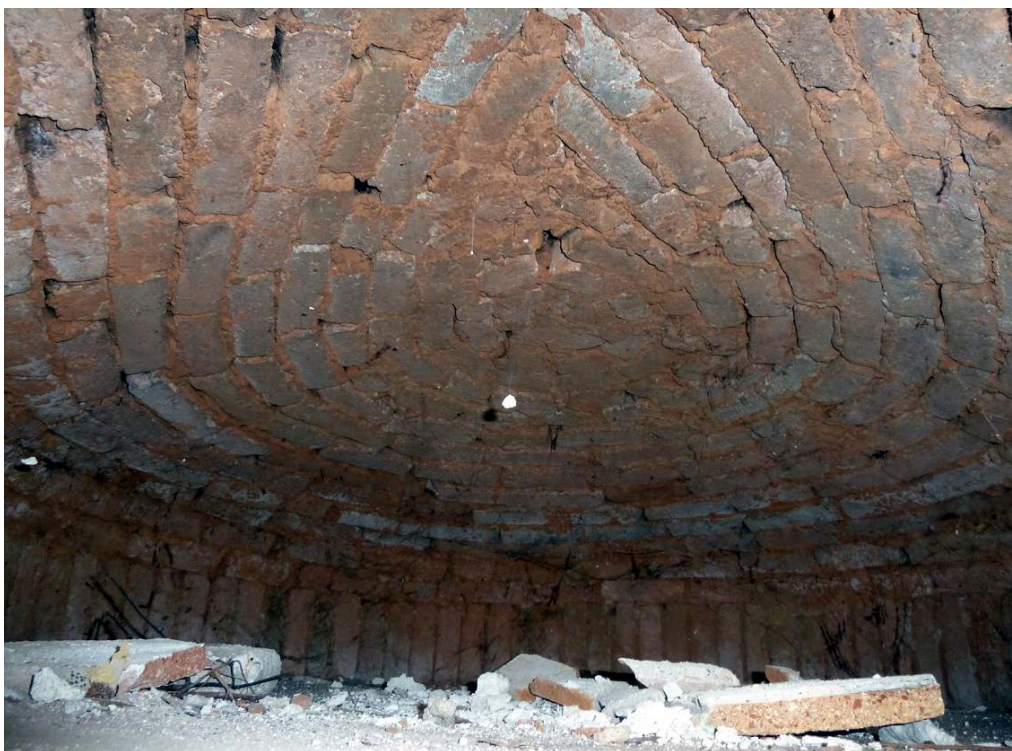
C/ SANT FELIU, 9 (Sabadell, Vallès Occ.). - Vista de l'interior de la cambra de cocció del forn de pa. La volta està feta de rajols col·locats concèntricament i la solera és de pedra.
