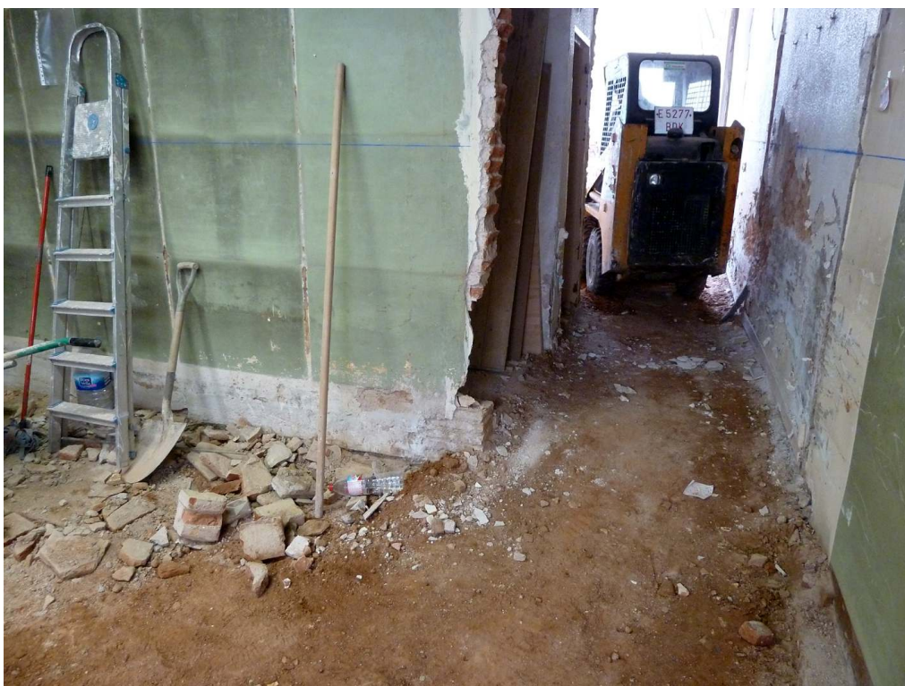
C/ SANT FELIU, 9 (Sabadell, Vallès Occ.).- Vistes del passadís on es pot veure les restes de morter de la preparació de l'enrajolat. Per s'observa el terreny natural d'argiles plàstiques, sense presència de restes arqueològiques de cap tipus.
