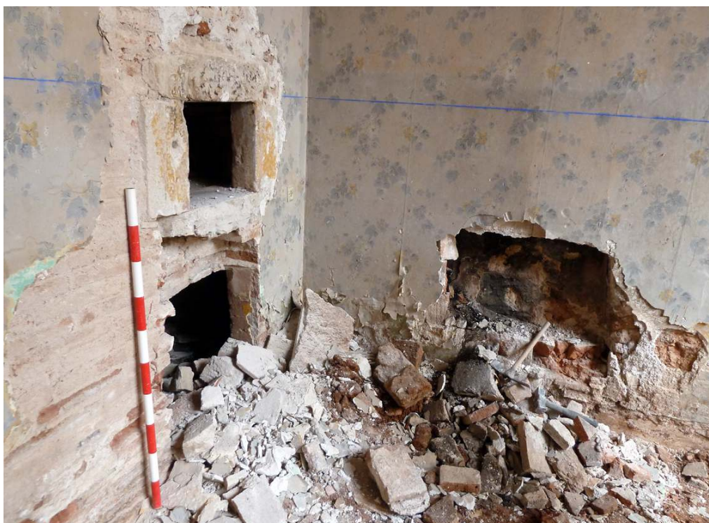
C/ SANT FELIU, 9 (Sabadell, Vallès Occ.).- Vista del forn de pa i llar de foc localitzats al cantó nord-oest de l'espai de control arqueològic, encastats en els murs del casal. Aquestes estructures permeten suposar que l'espai de la cuina s'hauria localitzat en aquest punt, i que, en remodelacions posteriors s'hauria traslladat al primer pis, a on és actualment.
