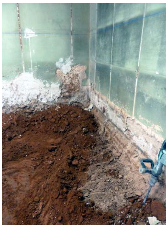
C/ SANT FELIU, 9 (Sabadell, Vallès Occ.).- Vistes de l'entrada durant els treballs de control arqueològic. Es pot veure el terreny natural que aflora per sota la capa de preparació de morter dels enrajolats.
