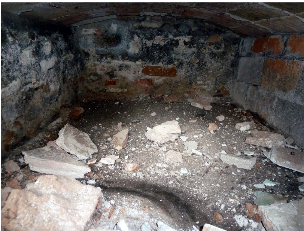
C/ SANT FELIU, 9 (Sabadell, Vallès Occ.). - Vista de la cendrera sota la cambra de foc del forn de pa. És de planta rectangular feta de rajols i morter i coberta amb volta rebaixada. Es poden veure restes de cendres i carbons que hi eren acumulades.
