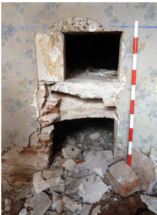
C/ SANT FELIU, 9 (Sabadell, Vallès Occ.).- Vista del forn de pa, de reduïdes dimensions. Es troba encastat en els murs del sota escala del casal.
