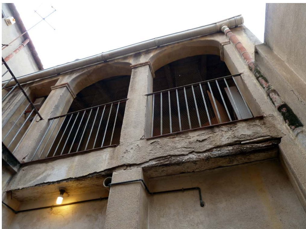
C/ SANT FELIU, 9 (Sabadell, Vallès Occ.). - Detall del cos lateral construït a mode de galeria. Aquesta estructura va ser enderrocada abans de començar la intervenció arqueològica.
