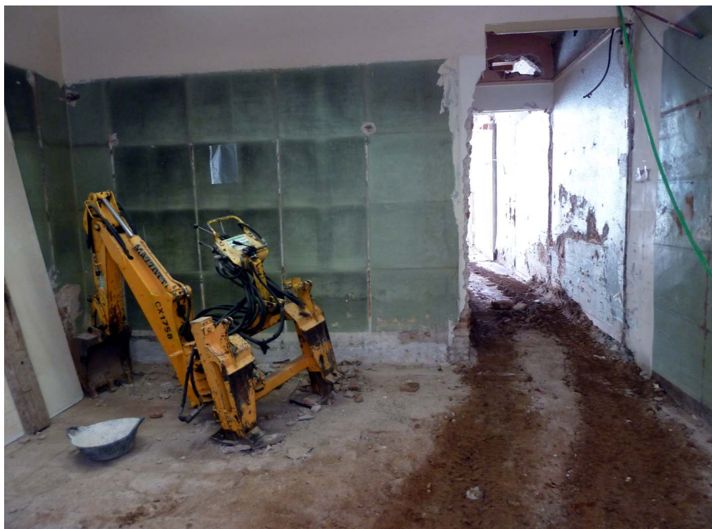
C/ SANT FELIU, 9 (Sabadell, Vallès Occ.). - Vista de l'entrada a l'inici dels treballs de control arqueològic. Es pot veure la capa de morter de preparació de l'enrajolat i el terreny natural que apareix just a sota.
