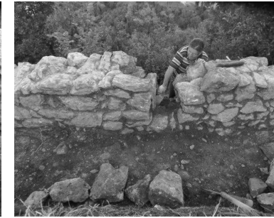
Figura 22. Treballs de consolidació de la UE4119
