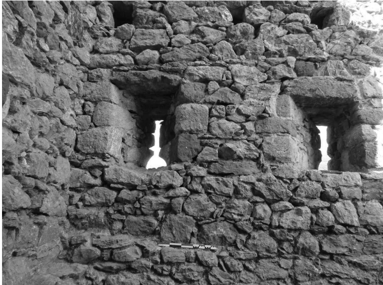
Figura 16. Interior de la bestorre: mur UE4128 en sentit est-oest, trones inferiors i forats de bastida
