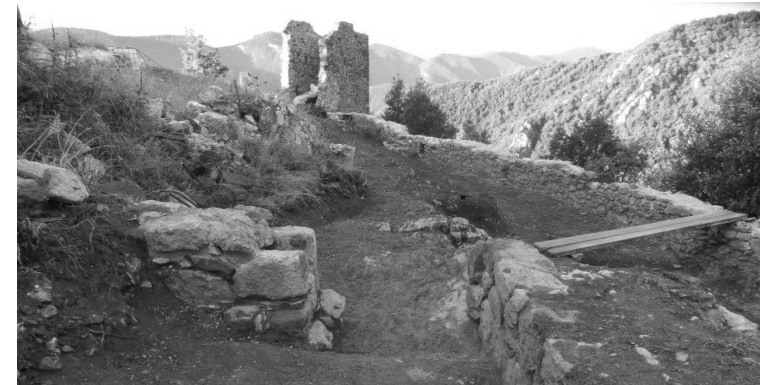
Figura 31. Vista de la porta UE6003 que dona accés a la Zona 4 des de la Zona 6 (nord)
