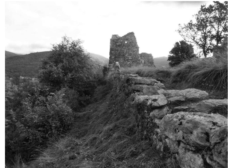
Figura 17. Neteja del mur UE4116 vist des del sud
