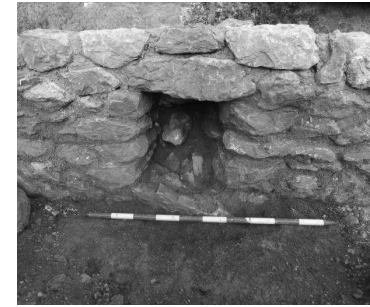
Figura 21. UE4118, espitllera o desguàs, des de l'interior.
