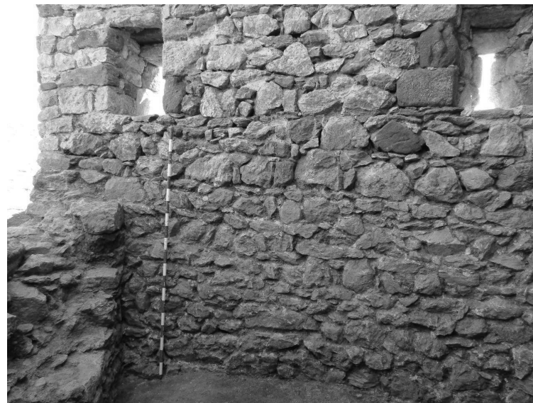
Figura 14. Interior de la bestorre: mur UE4126 en sentit oest-est, disposat sobre UE4116. Troneres
