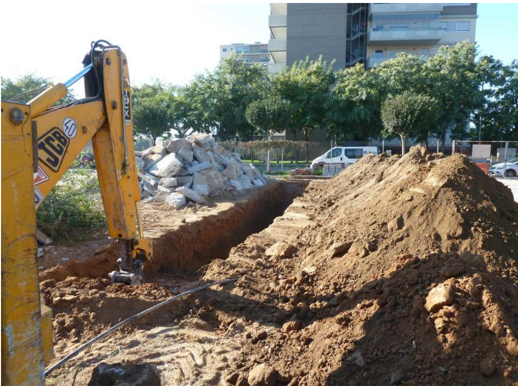
AV. DEL SOL, CAMÍ DEL MIG, CAN CODINA (Sant Joan Despí, Baix Llobregat). - Vista dels treballs d'excavació de la Rasa 3. Al fons es veu el Camí del Mig.
