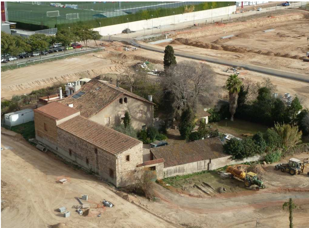
AV. DEL SOL, CAMÍ DEL MIG, CAN CODINA (Sant Joan Despí, Baix Llobregat). - Detall de la masia de Can Codina, situada tot just a uns metres de la zona de prospecció. L'estructura visible és d'època moderna i contemporània, però apareix als documents en època medieval.
