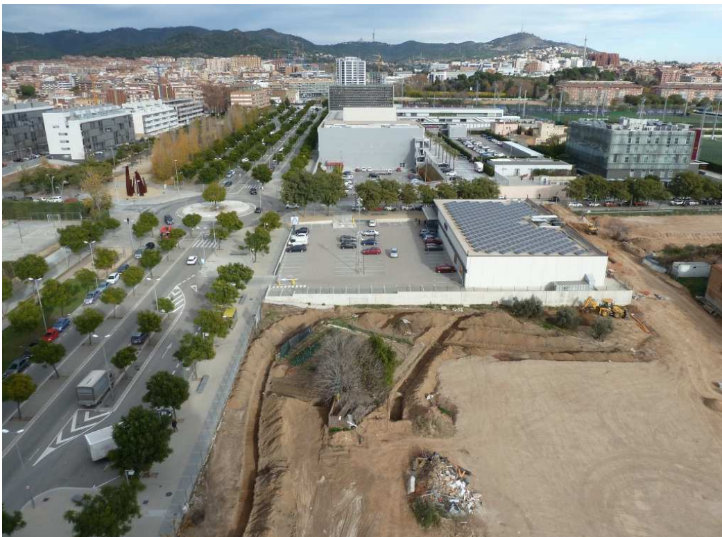
AV. DEL SOL, CAMÍ DEL MIG, CAN CODINA (Sant Joan Despí, Baix Llobregat). - Vista de situació de la parcel·la a on s'han efectuat els treballs. Es pot veure l'avinguda del Sol al costat esquerre. Al fons, la ciutat de Sant Feliu del Llobregat i la Serra de Collserola.
