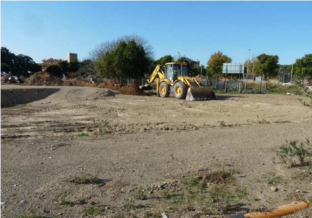
AV. DEL SOL, CAMÍ DEL MIG, CAN CODINA (Sant Joan Despí, Baix Llobregat). - Vista de l'inici dels treballs de prospecció arqueològica amb màquina excavadora amb pala plana, mitjançant rases de sondeig.
