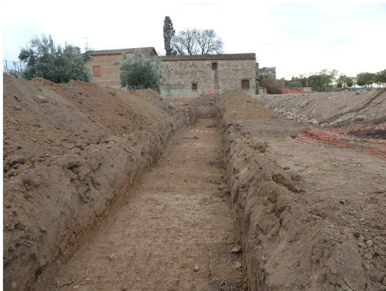
AV. DEL SOL, CAMÍ DEL MIG, CAN CODINA (Sant Joan Despí, Baix Llobregat). - Vista de la Rasa 8 que es disposa perpendicular a l'Avinguda del Sol i es troba situada al cantó sud del solar, proper a la masia de Can Codina.
