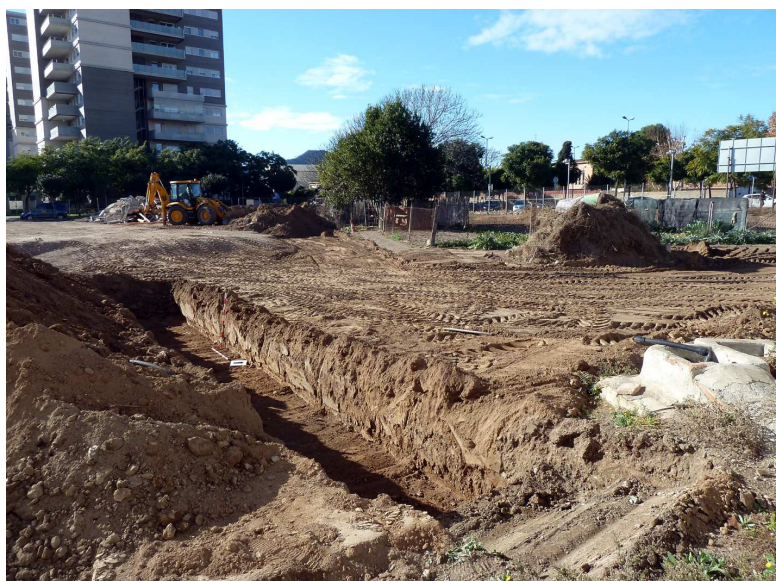
AV. DEL SOL, CAMÍ DEL MIG, CAN CODINA (Sant Joan Despí, Baix Llobregat). - Vistes de la Rasa 11 i 12, al costat est de la parcel·la, en el moment de ser tapades. No es van documentar restes arqueològiques.
