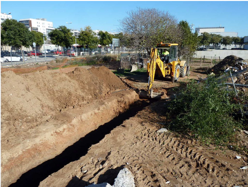
AV. DEL SOL, CAMÍ DEL MIG, CAN CODINA (Sant Joan Despí, Baix Llobregat). - Detall dels treballs d'excavació de la Rasa 3 amb màquina excavadora de pala plana.
