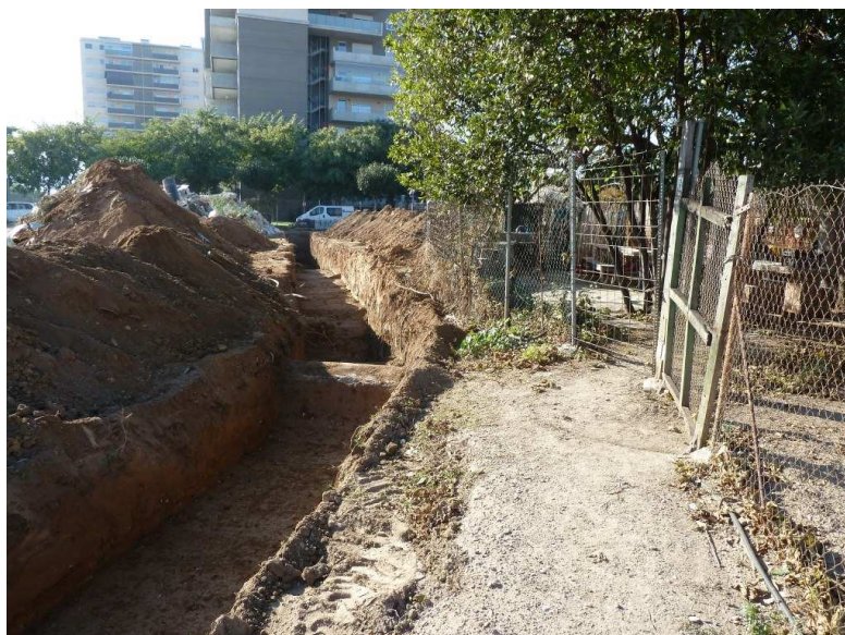
AV. DEL SOL, CAMÍ DEL MIG, CAN CODINA (Sant Joan Despí, Baix Llobregat). - Vista de la Rasa 3 al seu pas pel cantó sud de l'hort.
