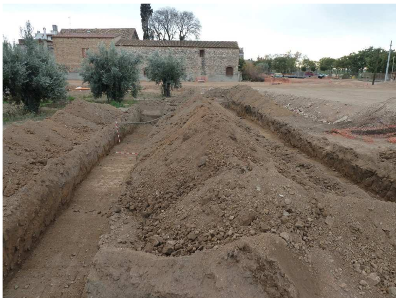
Vista de la Rasa 10 (esquerra) i la Rasa 8 (dreta), totes dues, en el cantó sud del solar, a tocar la masia de Can Codina que es veu al fons.
