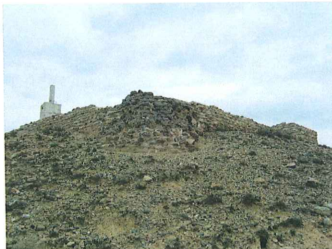
Vista de la fortalesa des de la vessant
