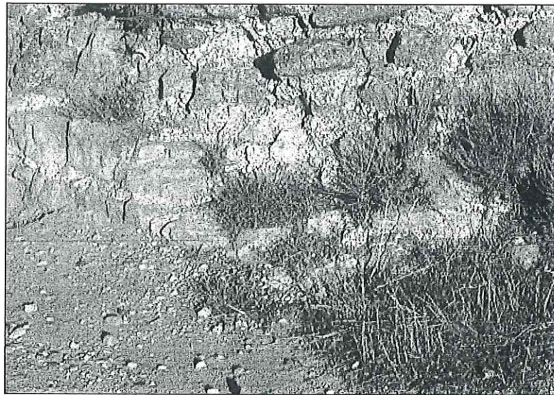
Pell exterior de pedra arenosa concertada. Nucli de còdols i pedres rieres.
