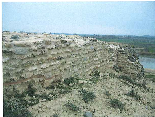
Vista del mur oest i de la torre cantonera
