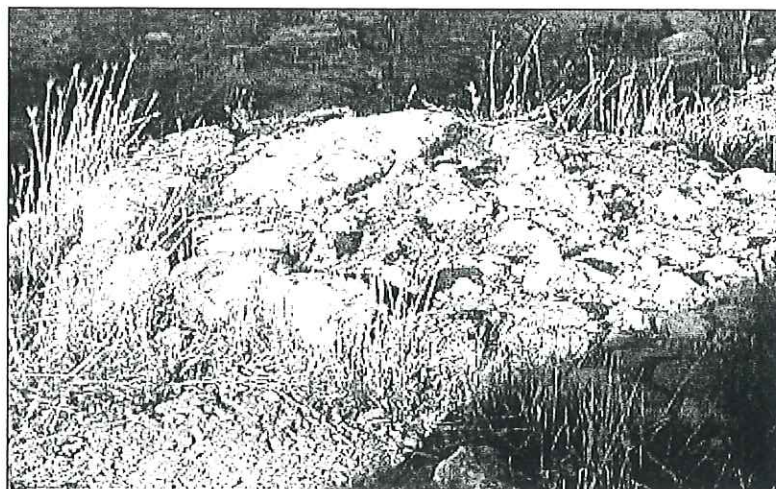
Detall de la base, fonaments, dels murs circumdants de la torre.
