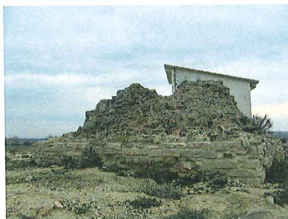
Vista de la torre
