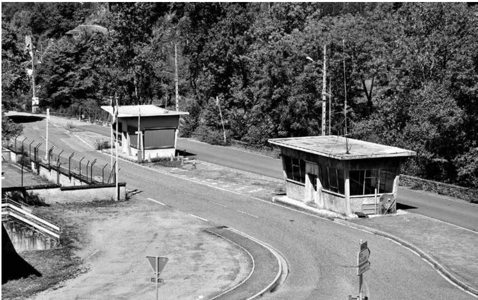
Estat actual de la darrera duana que va funcionar fins l'entrada en vigor de l'espai Schengen el 1995, amb les casetes dels controls francès i espanyol. Està situada en el terme de Melles, a l'entrada de la població d'Hòs (la número 5 en la diacronia duanera).
