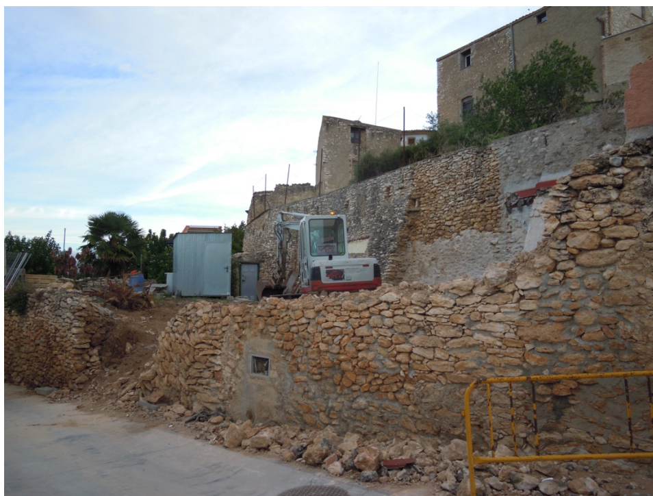
19. Vista general des del nivell inferior del c. del Pou un cop completat els enderroc, en el moment d'iniciar el rebaix de la finca.
