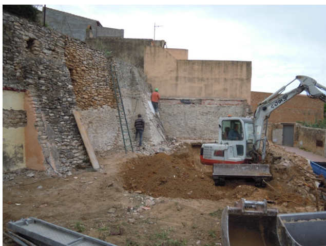
23, 24. Vista del rebaix mecànic i de l'enderroc manual de les restes adossades a la muralla. A la dreta el moment en què aparegué la mina UE 18, i visible el forat d'accés a la mina UE 16 en la base de la muralla.
