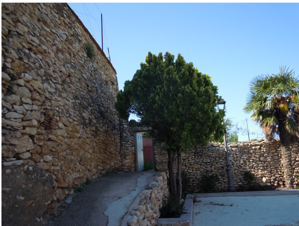
4. Vista general de la finca on s'ha dut a terme la intervenció des de la plaça adjacent, des del lloc on es troba la porta d'accés. A l'esquerra el traçat de la muralla.
