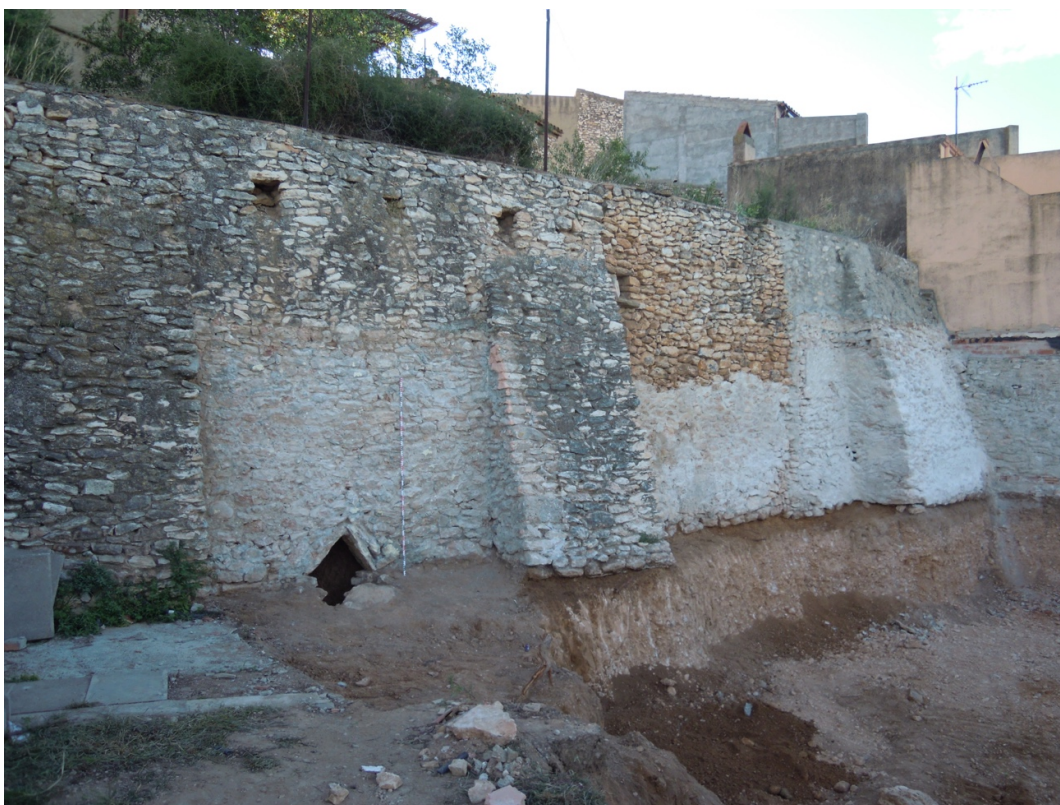
64. Vista general de la muralla un cop finalitzats els rebaixos i enderrocs i visible tot l'alçat, amb la mina que la trenca i la travessa (UE 16).
