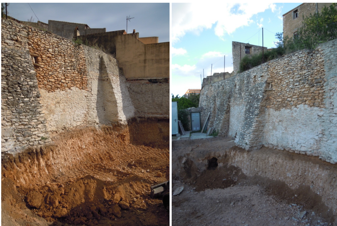
62, 63. Vistes del tram de muralla un cop finalitzat el rebaix i els enderrocs, des de l'extrem nord de la finca (esquerra) i des de l'extrem sud (dreta).
