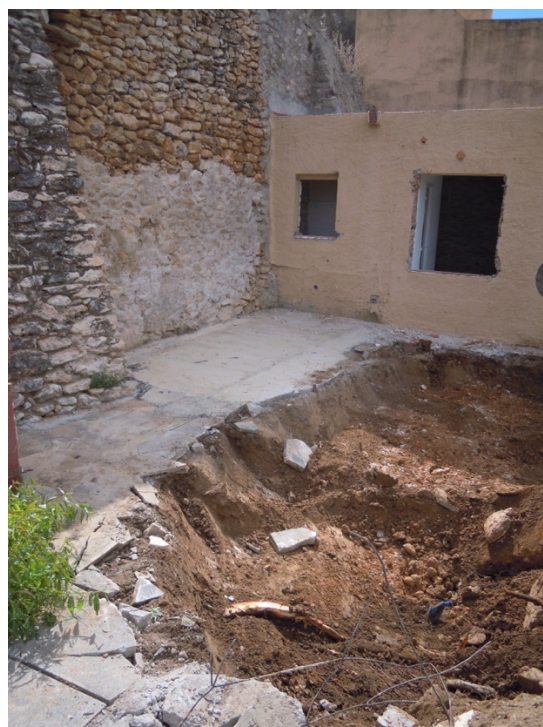
13, 14. Detall de l'enderroc del marge que dona al carrer -UE 19- i del rebaix inicial per crear la rampa d'accés a l'interior de la finca.
