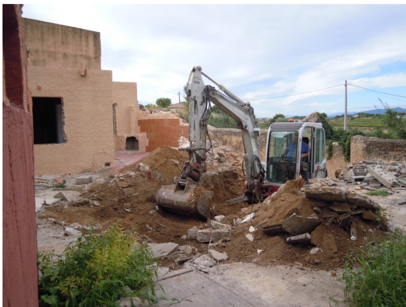
12. Detall dels moments inicials, un cop obert un accés al mur de pedra i fang UE 19, i començant l'enderroc.
