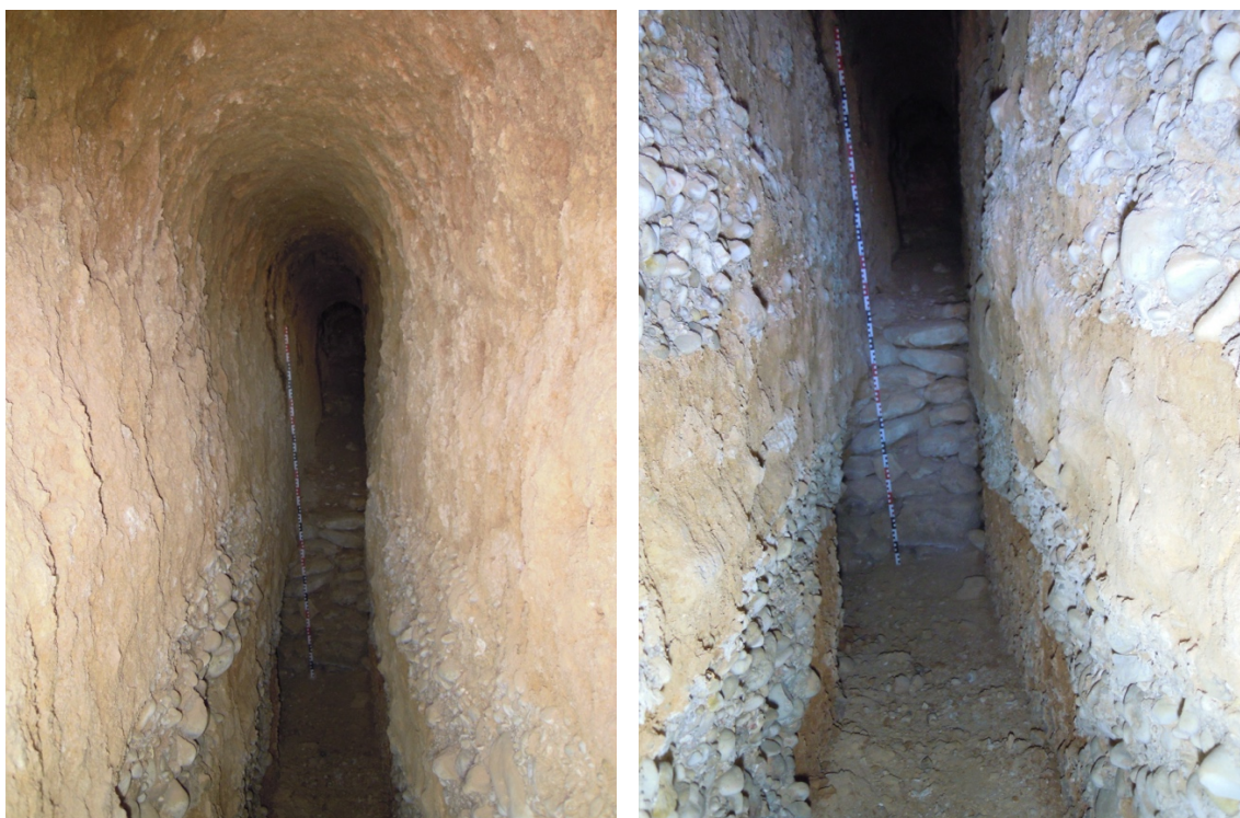
41, 42. Vista general i de detall del tram de la mina UE 16 situat sota la finca veïna, al punt en què s'aixeca la solera, coincident amb el punt on desemboca la mina UE 17.
