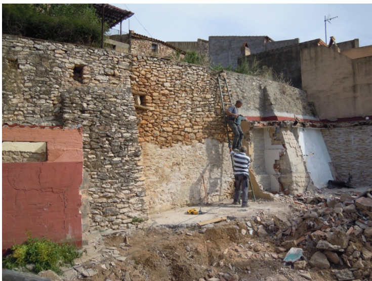
17, 18. Detall dels treballs d'enderroc manual de la zona de la caseta, amb la barraca d'eines abans i després de l'enderroc.
