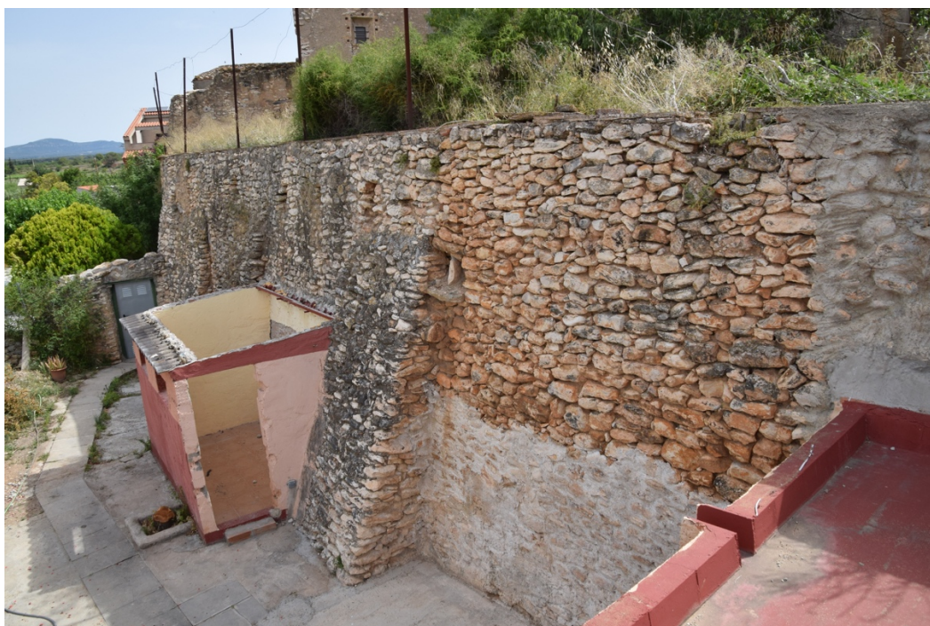
5. Vista general de la finca amb la muralla a la dreta, vista des de la coberta del magatzem-caseta previst enderrocar.
