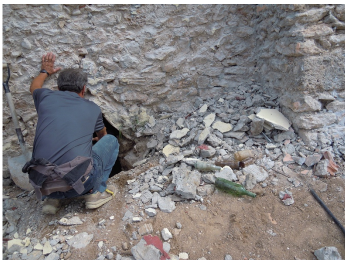
21, 22. Detall dels treballs finals d'enretirada de la capa de pòrtland adossada a la muralla i descoberta de la mina en la zona de traspàs de la pròpia muralla. A la dreta detall de l'interior, amb quantitat de runa i altres elements (ampolles i llaunes de beguda, plàstics, etc) acumulats en aquest accés.
