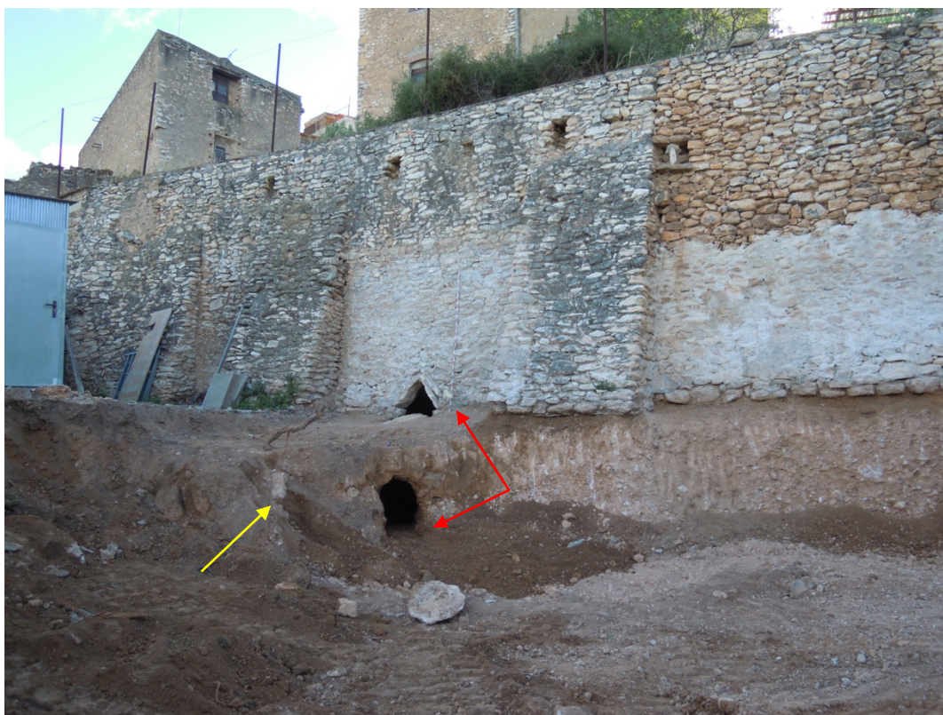
32. Vista de detall del pany de muralla per on travessa la mina UE 16, així com del tram conservat en la finca rebaixada, visible al perfil en procés de neteja. En vermell la mina UE 16 i en groc l'UE 18.
