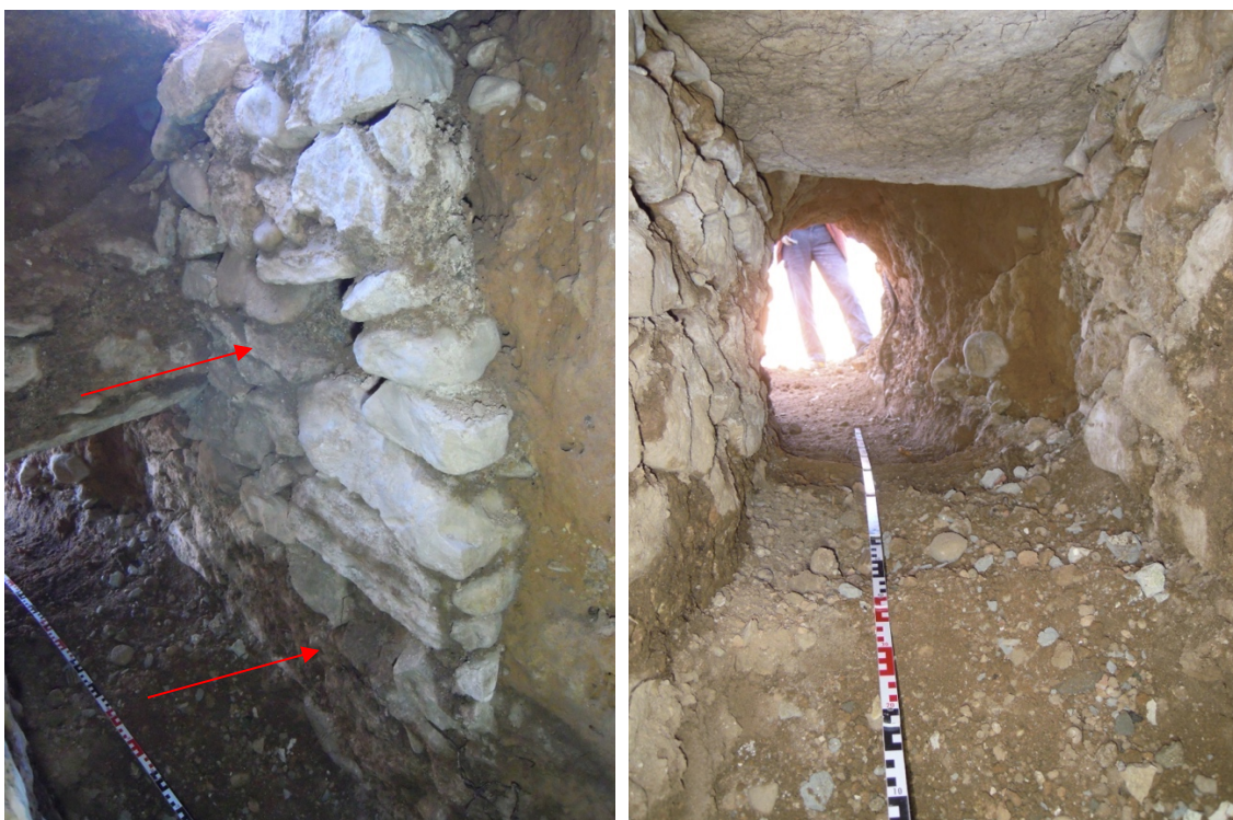
37, 38. Esquerra: detall del muret de reforç a la zona de traspàs de la muralla, amb els encaixos laterals per a recolzar el peu. Dreta: detall del tram situat a l'entrada de la mina en la finca núm. 16 del c. del Pou, un cop passat l'accés del registre.
