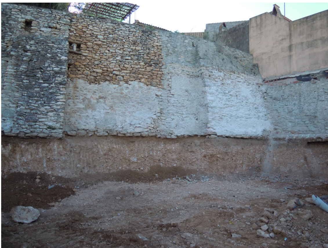
71. Vista general de la muralla a la fi dels treballs, amb el tram central i meridional.
