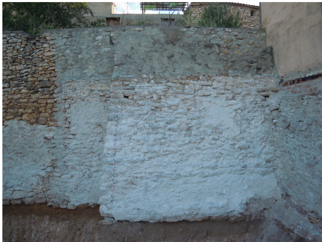
67. Detall del contrafort UE 5, conservat a l'angle sud-est de la finca, un cop extreta la capa de morter i de rajoles que el tapava.
