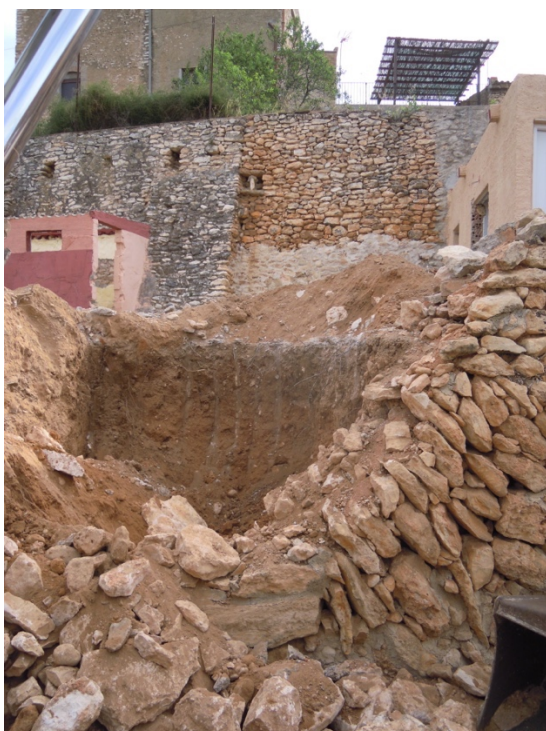
13, 14. Detall de l'enderroc del marge que dona al carrer -UE 19- i del rebaix inicial per crear la rampa d'accés a l'interior de la finca.
