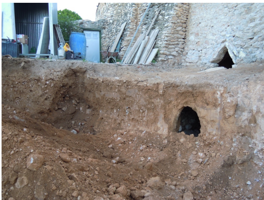
55. Detall del perfil un cop extret el tram de mina amb coberta de lloses UE 18, i comprovat que darrera quedava el retall farcit per terra i runa (a l'esquerra). A la dreta el perfil amb el tram conservat de la mina UE 16.
