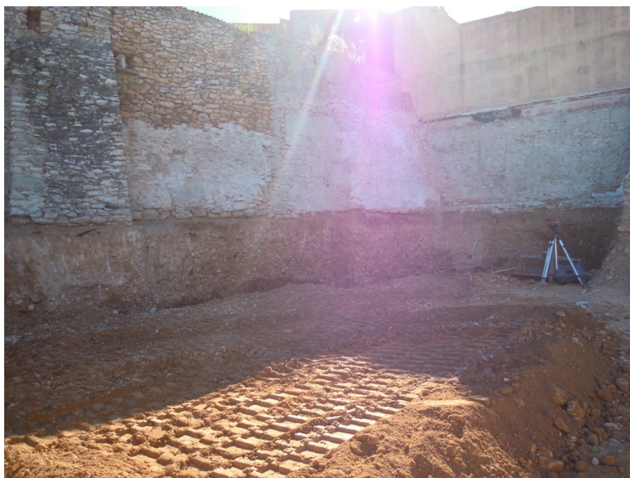
61. Vista general del sector central i meridional de l'àrea d'actuació, un cop finalitzats el rebaix i les deconstruccions previstes.
