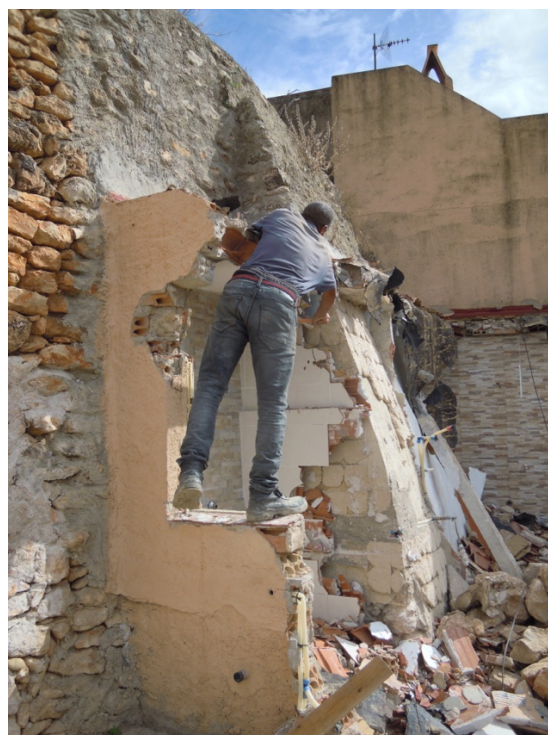
15, 16. Detall dels treballs d'enderroc combinant els mitjans mecànics i manuals per a les zones de contacte amb la muralla. A la dreta es pot veure l'enrajolat adossat al contrafort UE 5.
