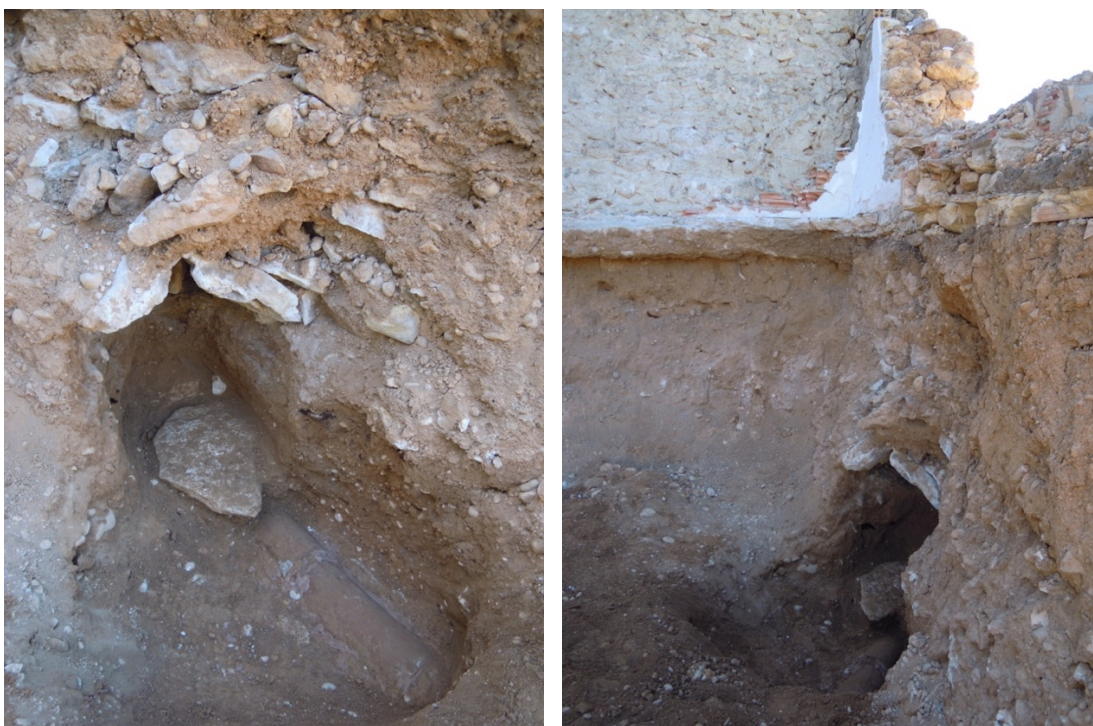
51, 52. Detalls de la mina UE 18 en la zona en què travessa el mur-marge UE 19 per anar a buscar, originalment, la bassa situada a l'altre costat del c. del Pou.
