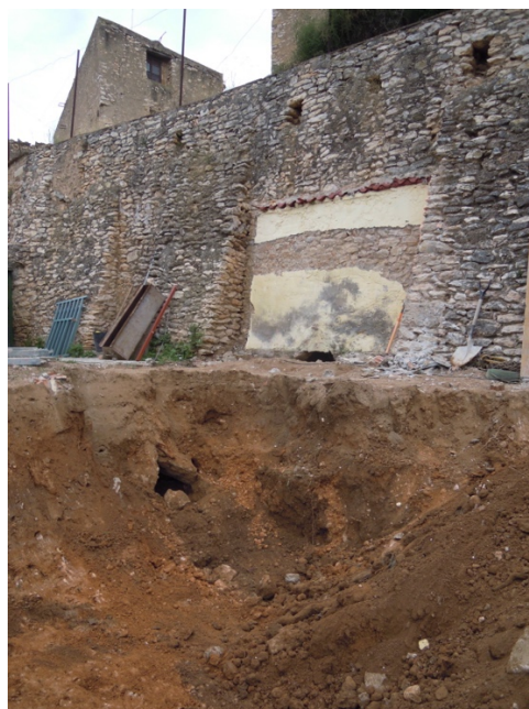
23, 24. Vista del rebaix mecànic i de l'enderroc manual de les restes adossades a la muralla. A la dreta el moment en què aparegué la mina UE 18, i visible el forat d'accés a la mina UE 16 en la base de la muralla.
