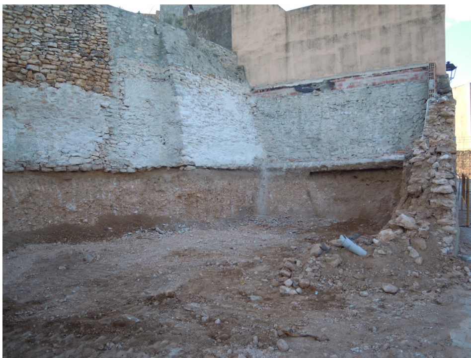
28. Vista de la zona central i sud del solar un cop finalitzat el rebaix mecànic. S'ha mantingut el mur de pedra i fang UE 19, on s'hi obre la mina UE 18, per procedir a la seva documentació.
