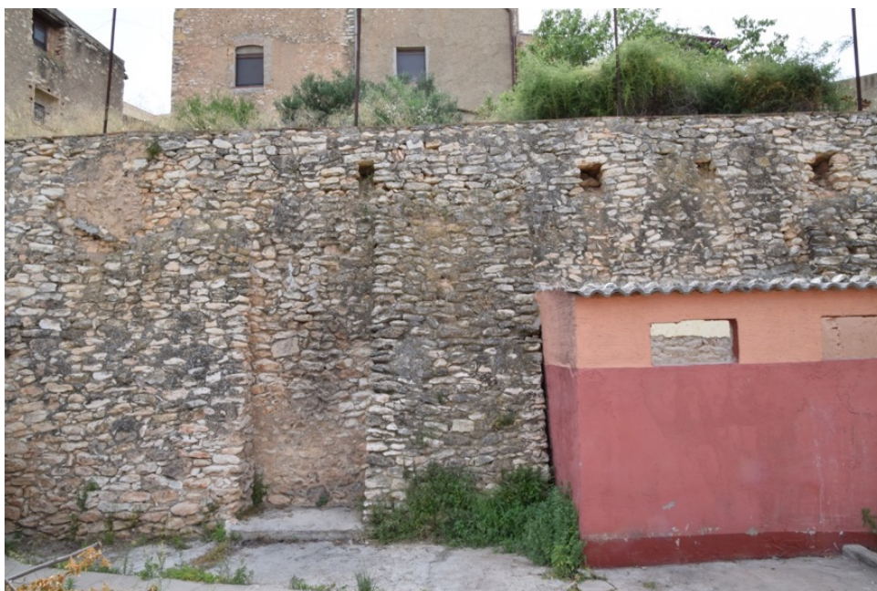
10. Vista general de la meitat nord del tram de muralla documentat a la intervenció del mes de juny de 2022, amb els contraforts descrits i les espitlleres en el nivell superior
