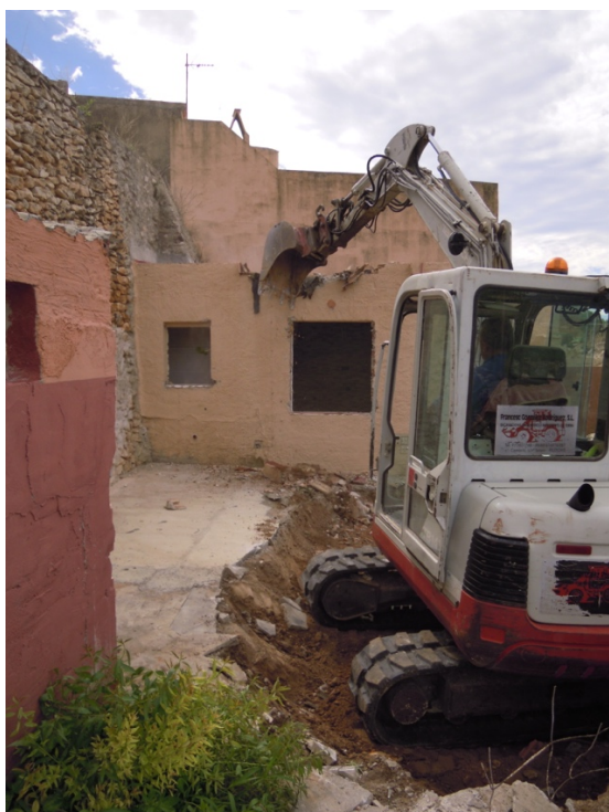
15, 16. Detall dels treballs d'enderroc combinant els mitjans mecànics i manuals per a les zones de contacte amb la muralla. A la dreta es pot veure l'enrajolat adossat al contrafort UE 5.
