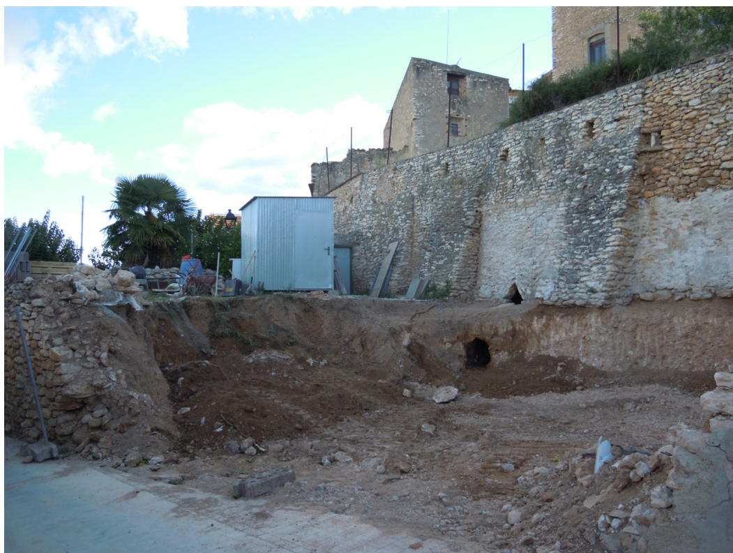
65. Vista general de la muralla un cop finalitzats els rebaixos i enderrocs, on es pot veure al perfil el retall de la mina que la travessa.
