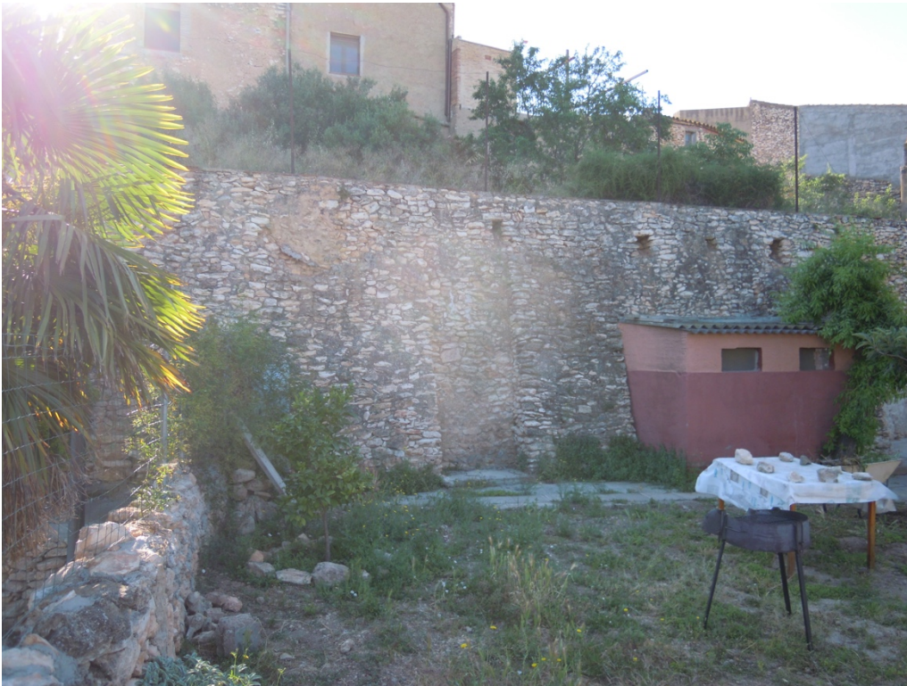
6. Vista general del pany de muralla situat entre el punt d'accés i la barraca d'eines previst enderrocar.
