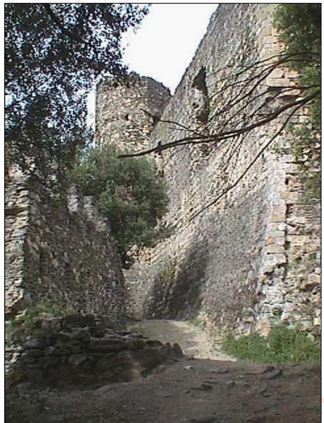
Foto 1. Vista externa del recinte sobirà.
