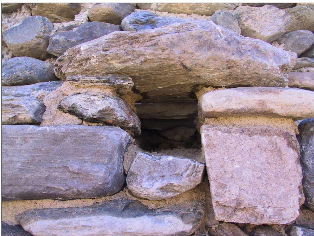
Foto 9. Forat de bastida reconstruït. Any 2003.
