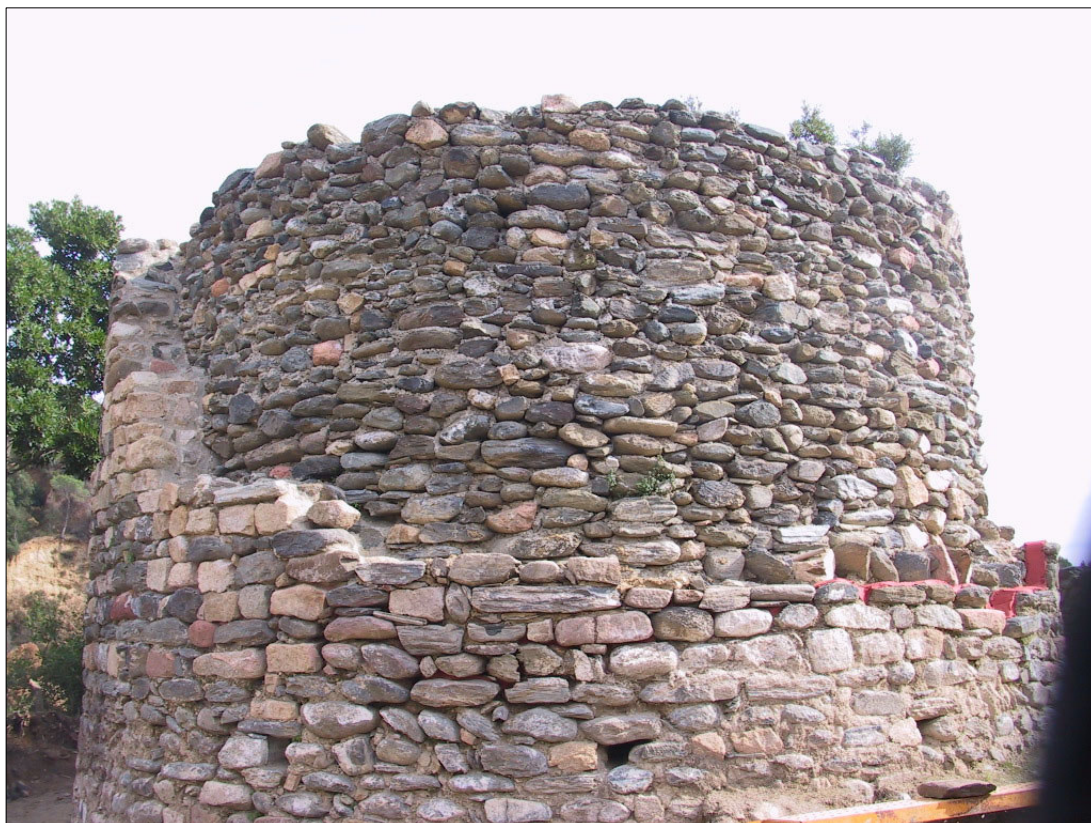
Foto 4. Reconstrucció interior. Any 1998.
