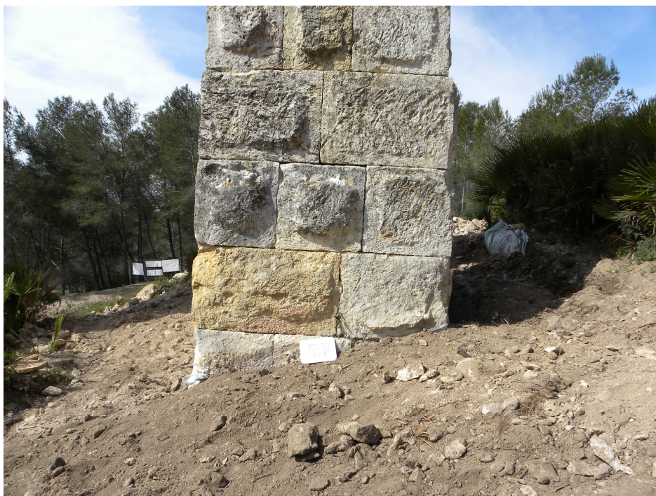
foto 38 vista de la cara est del P23 una vegada finalitzades les feines
