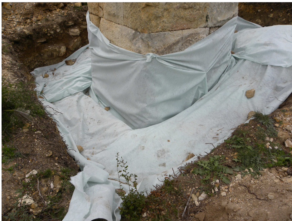
foto 36 vista del pilar 23 una vegada coberta la base amb geotèxtil
