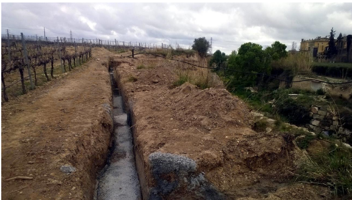
Fotografia 3. BB_2_2016_ Vista de la rasa occidental amb la sabata en curs de ser omplerta de formigó_JVallverdu
