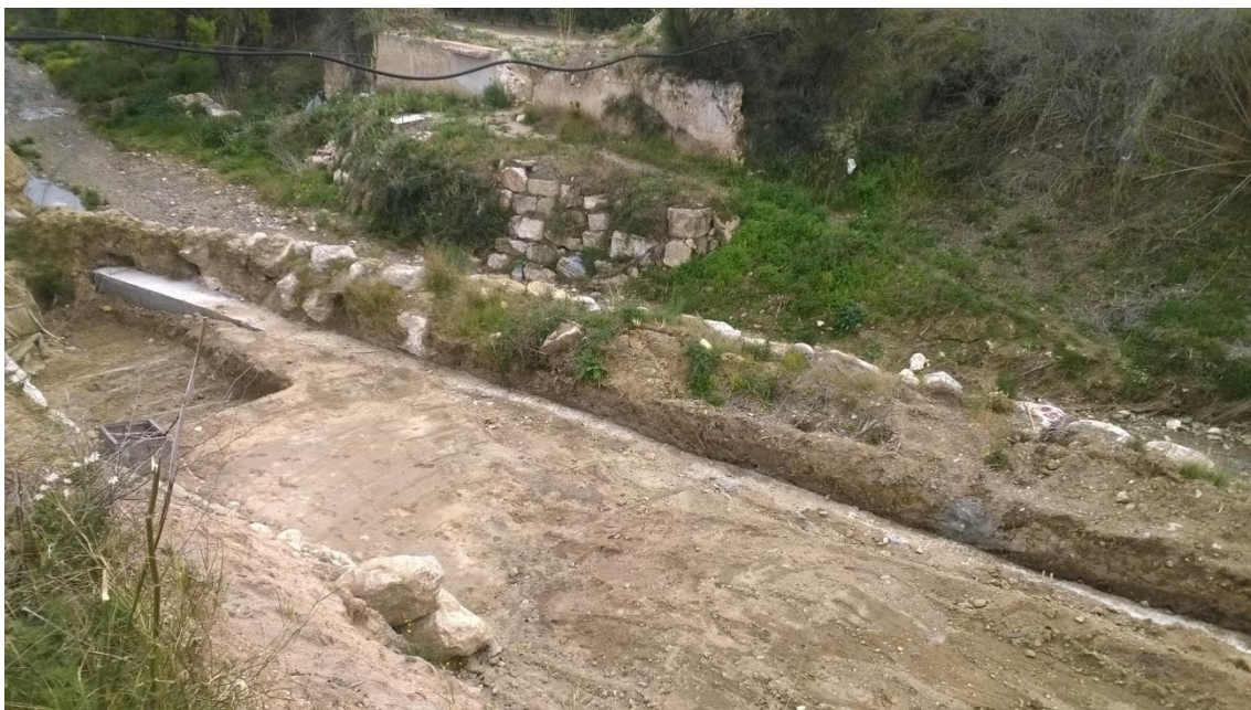
Fotografia 2. BB_2_2016sta de la sabata oriental de la marquesina de la cala 2 durant la seva construcció_ J. Vallverdú
