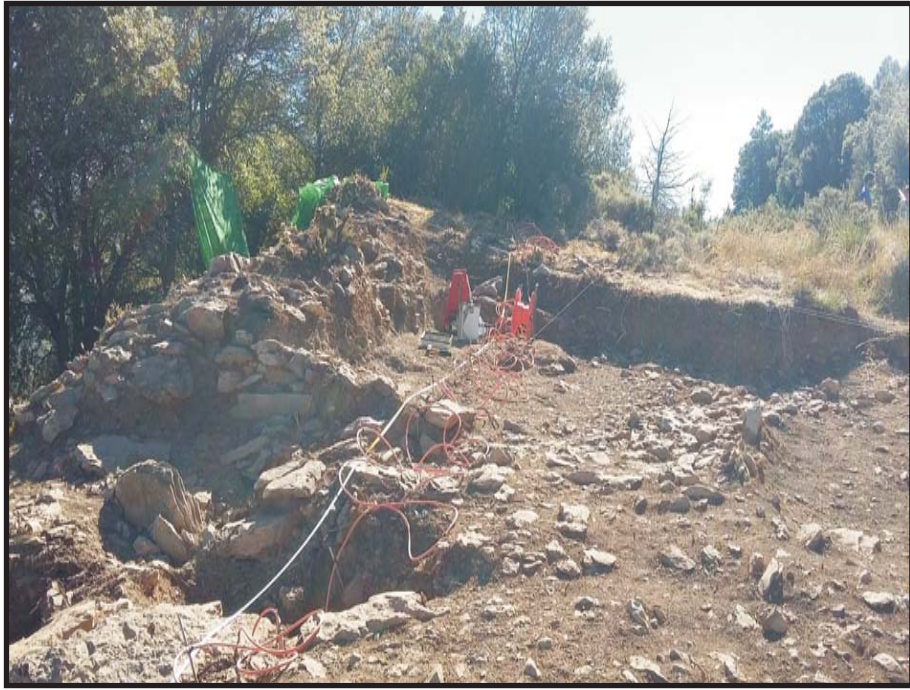
Fotografia 1. Tram del perfil PTE-1
