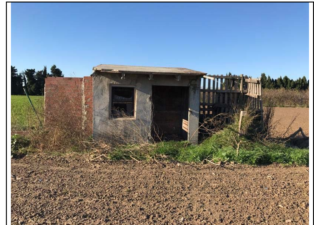
Foto 15: E.D. 2, : caseta d'obra de forma quadrada arrebossada amb ciment i coberta plana, destinada a tasques del camp.
