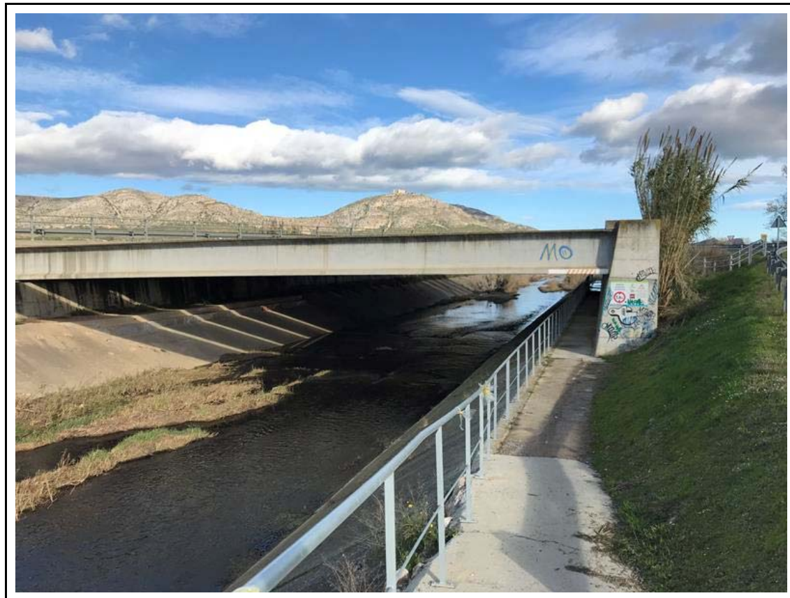
Foto 16: A.P. 3, Inici prospecció. Riu Daró Canalitzat.
