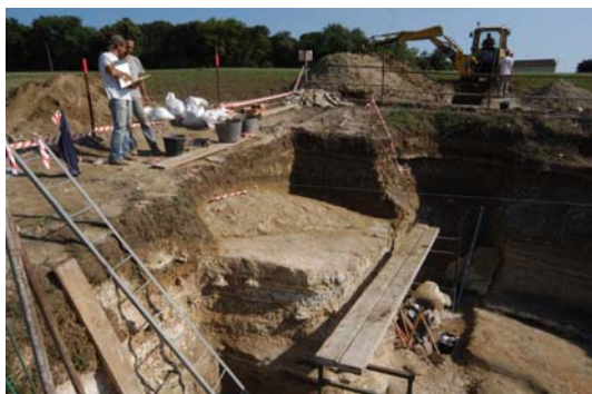
Fig.13. Vista de l'excavació amb màquina de la Cala 12
