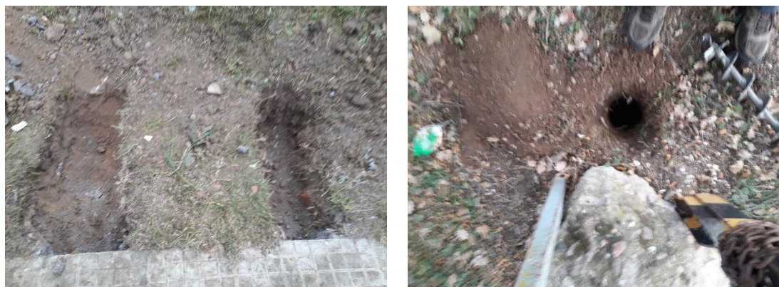
Figura 6. Excavació rases de fonamentació B4 (esquerre) i excavació C4 (dreta)
