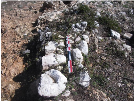
MR 1012 previ a la consolidació
