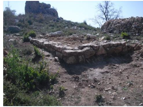
Vista recinte 6 un cop consolidat
