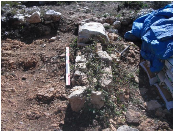
MR 1009 previ a la consolidació
