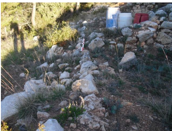
MR 1001 previ a la consolidació
