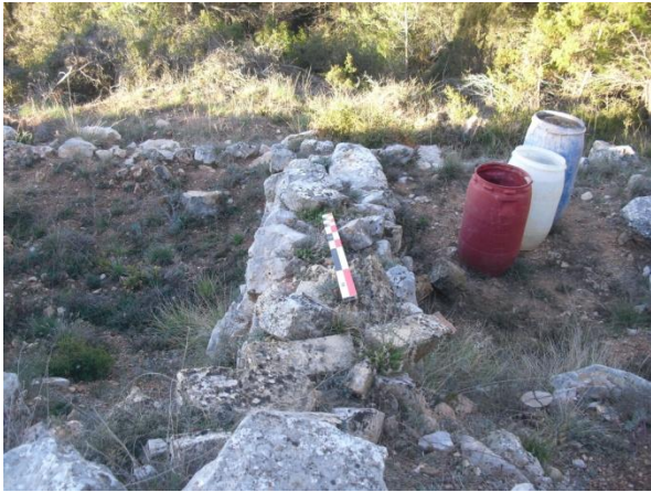
MR 1003 previ a la consolidació
