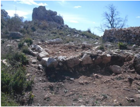
Vista del recinte previ a la consolidació
