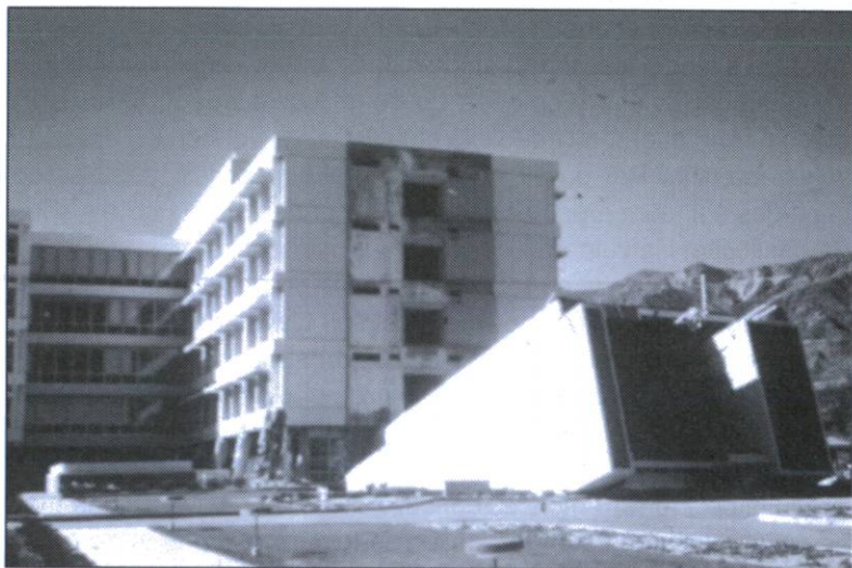
Edifici tombat per efecte de la líquefacció del sòl durant el terratrèmol de San Fernando, Califòrnia (1971).
