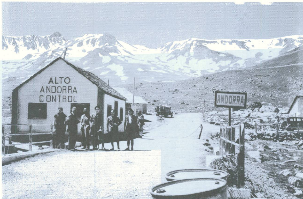
Pont fronterer (Pas de la Casa).
