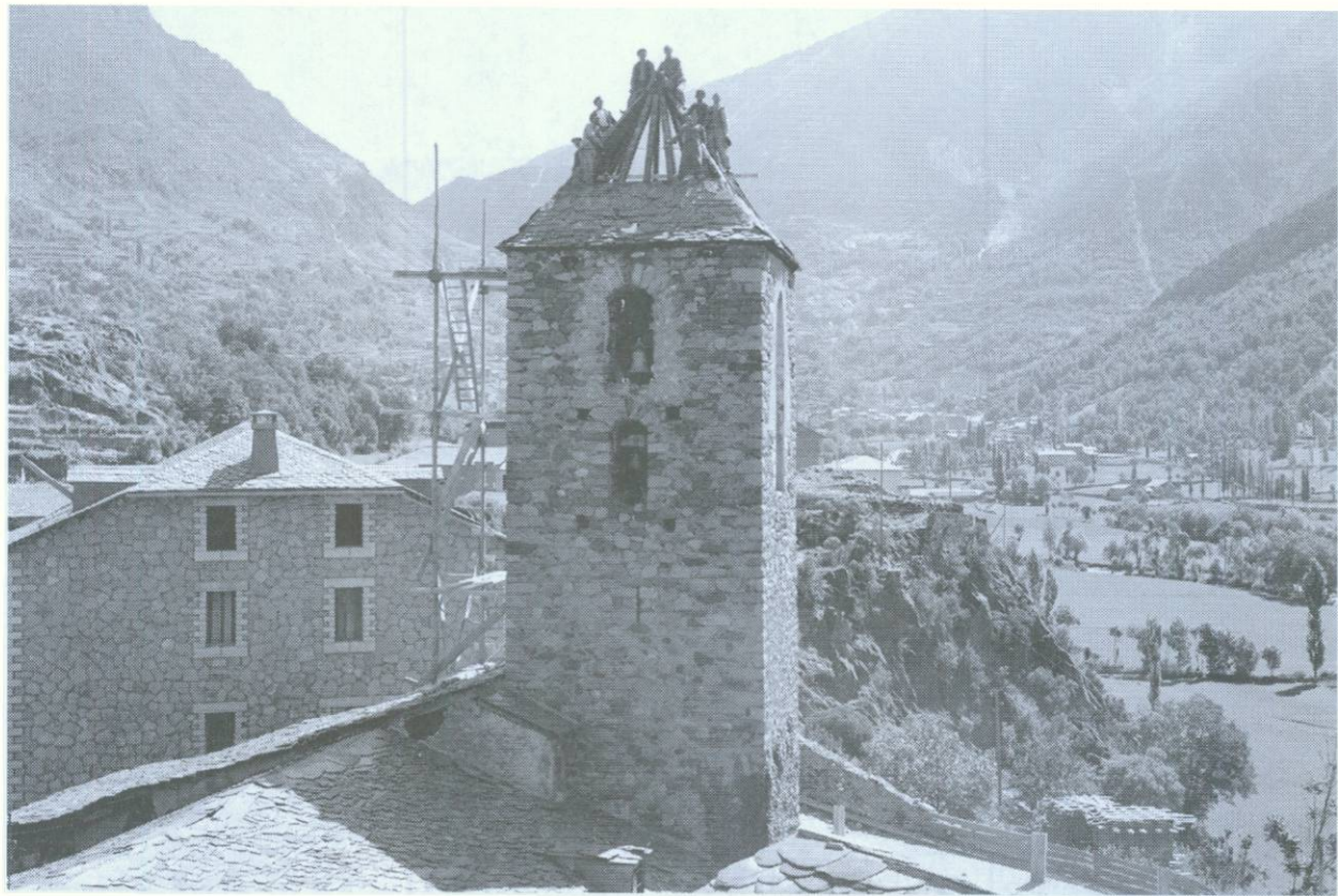
Aixecament d'un pis del campanar de l'església romànica d'Andorra la Vella segons el projecte de J. Puig i Cadafalch (Andorra la Vella).
