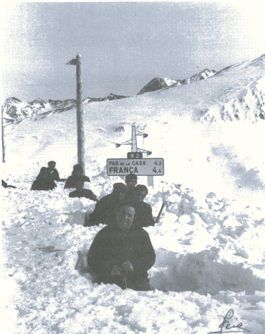
Obertura del port d'Envalira (1957-1958).
