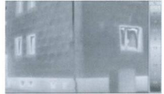
Edifici abans i després d'una rehabilitació amb millora de l'aïllament tèrmic.
