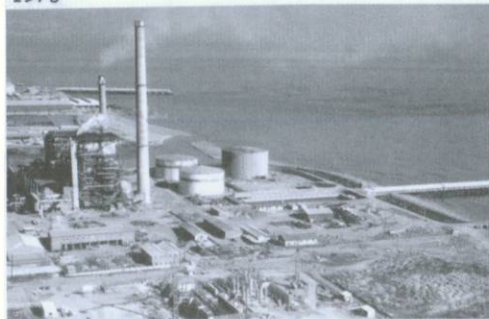
Figura 11. Centrals tèrmiques al Besòs.
