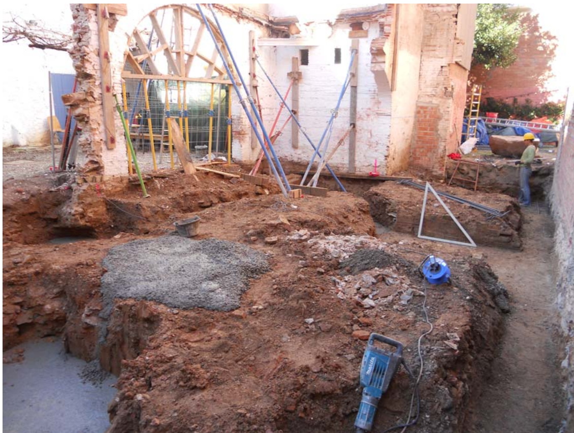
CA-14-274. Vista general al final del seguiment.
