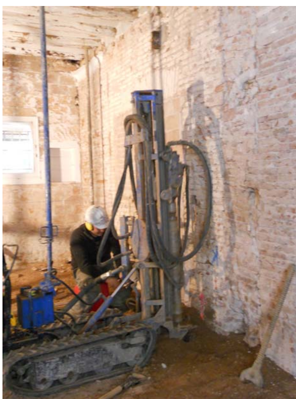
Treballs de micropilotatge
