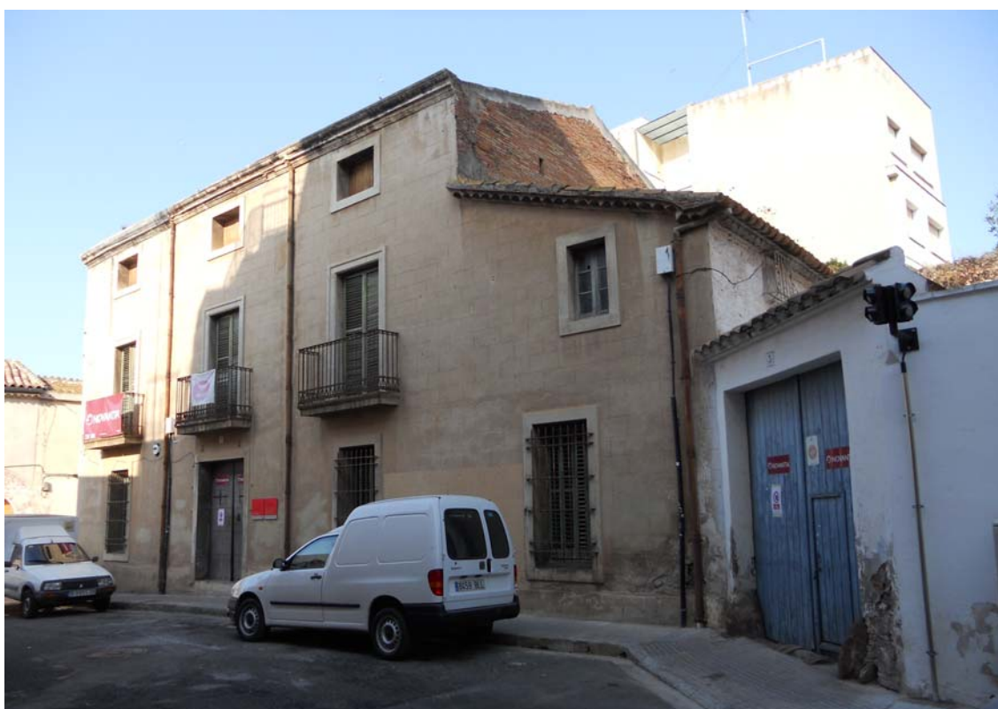
Imatge de la façana dels carrer de les Sitges.
