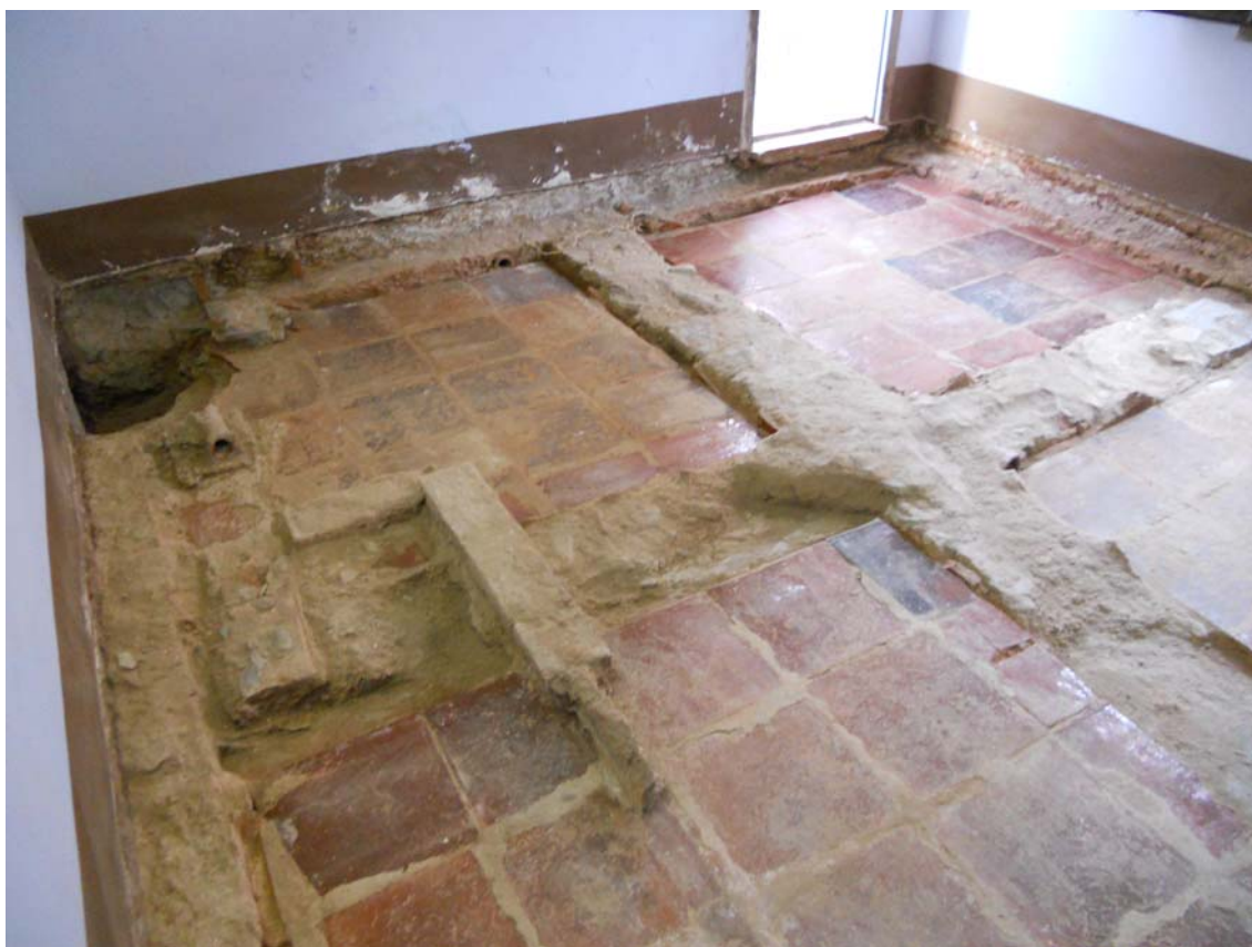
Vista general dels cups de la sala 2.
