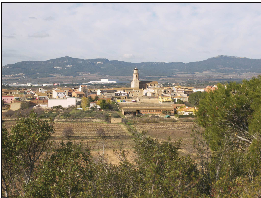
Foto superior : Emplaçament de la torre 76. Foto inferior : Vista general del nucli d'Alió, on hi ha diversos elements de patrimoni arqueològic i arquitectònic inventariats, i que es troba a més d'un quilòmetre al nord del traçat de la línia.
