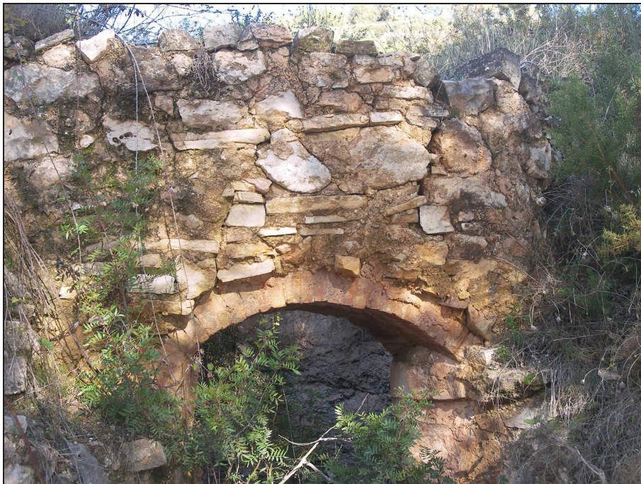
Detall de l'entrada, amb l'estructura de l'entrada feta amb rajols i les parets de pedres lligades amb morter.
