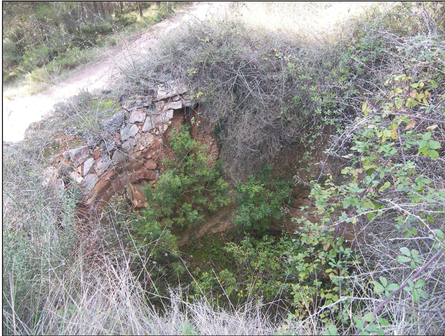
Vista general de l'interior del forn, totalment omplert de vegetació.
