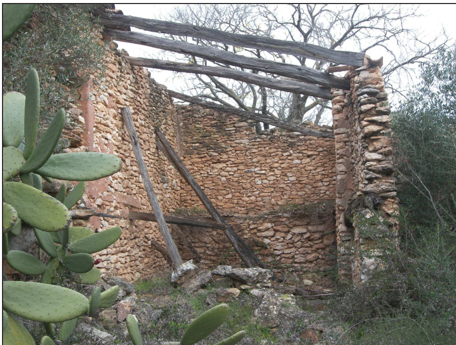
Vista general de l'estat actual de la pallissa.
