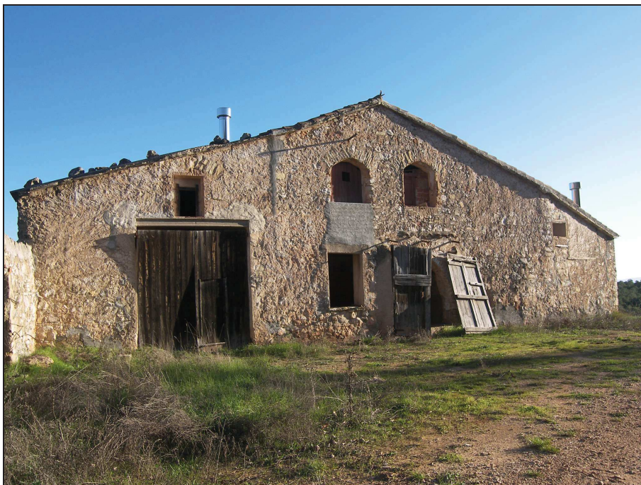
Foto superior: Emplaçament de la torre 12. Foto inferior: Mas d'en Bosc, actualment abandonat, situat en una zona propera al projecte i no afectat per les obres.
