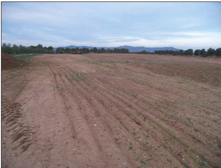
Foto superior: Emplaçament de la torre 63. Foto inferior: Emplaçament de la torre 64.
