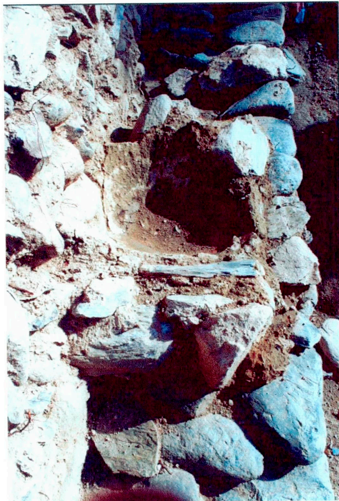
6. Àmbit F. Detall del mur MR-14
