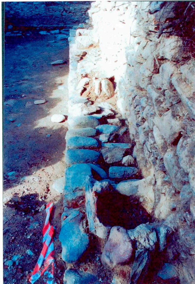
5. Àmbit F. Mur MR-14
