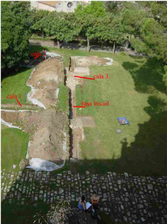
Aspecte general de les rases i cales obertes vistes des del transepte
