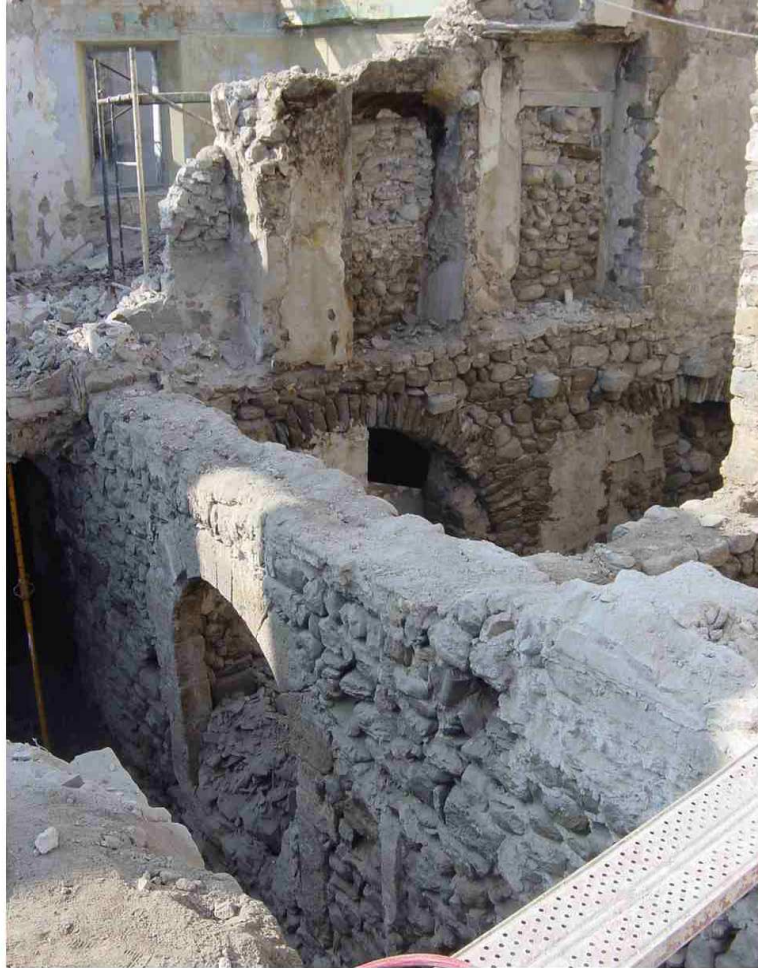
Enderroc d'estructures del primer pis.
