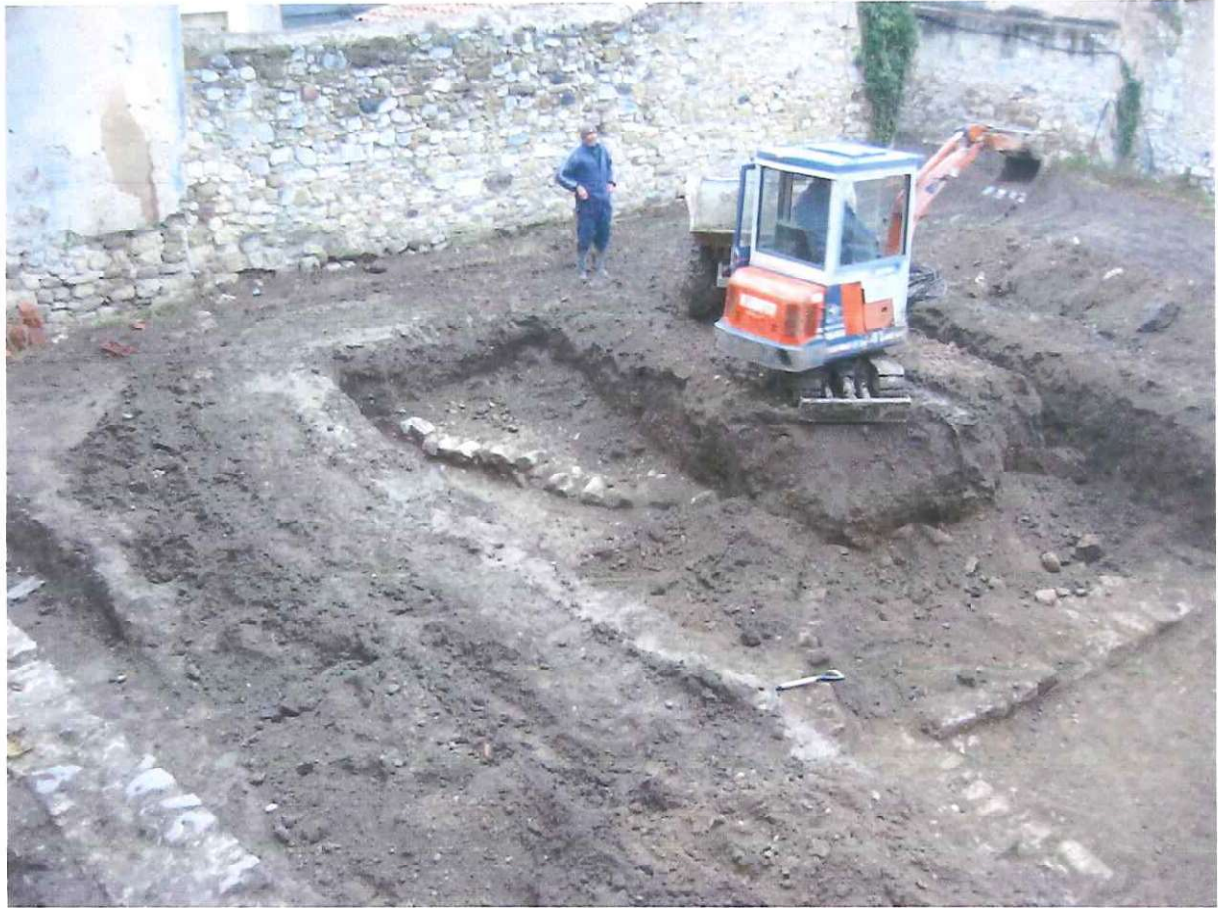
Procés d'obertura de la cala general que va comportar l'eliminació de les rases inicials.
