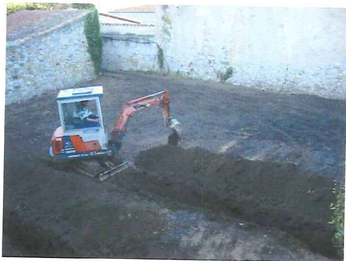
A l'esquerra i a baix. Procés d'obertura de les rases inicials
