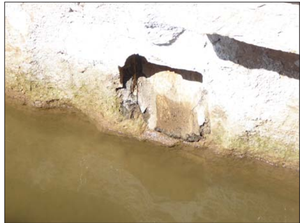
Fig. 12. Detall de la sortida de l'aigua del cup a l'interior de l'espai on hi hauria el rodet.
