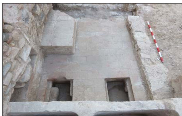
Fig. 18. Detall de les obertures per on s'abocava el residu aquós de la part baixa de les piques a la conducció que el treia cap a l'exterior. A la part superior de la imatge s'observa l'empremta del punt de subjecció central de la biga.
