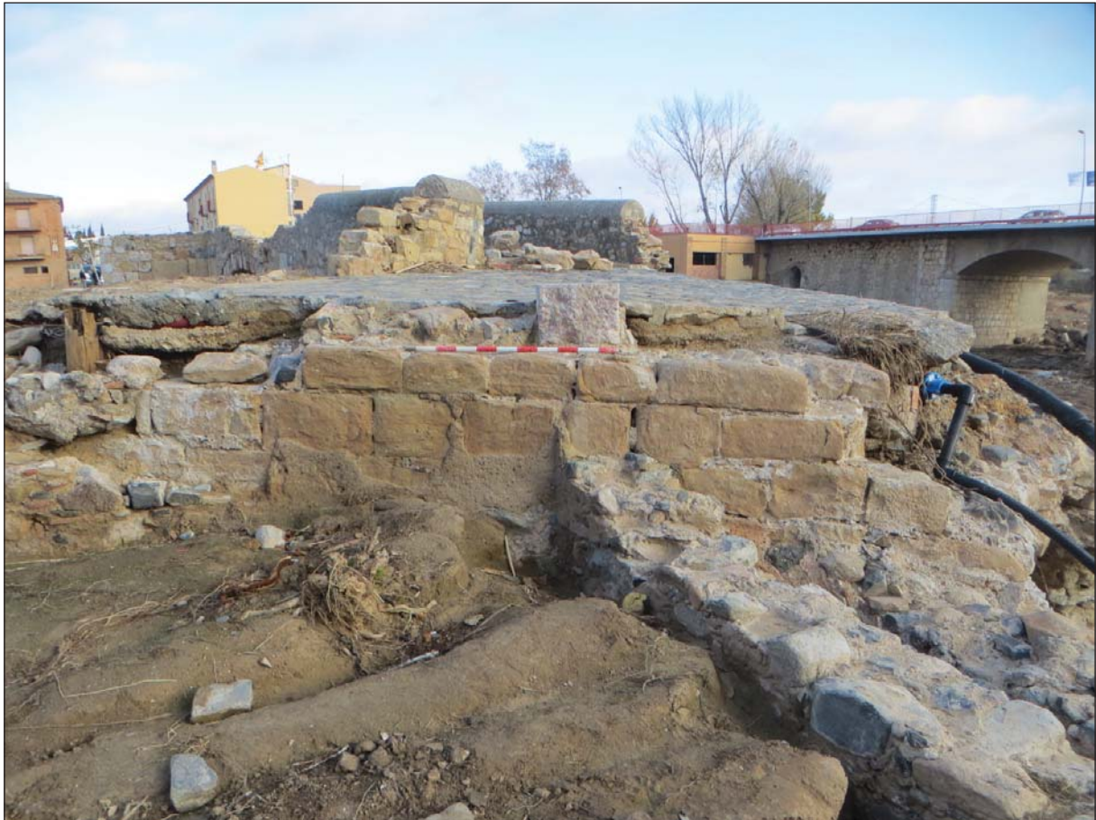
Fig. 25. Vista del nou tallamar del pont Vell, aparegut a conseqüència de la riuada.
