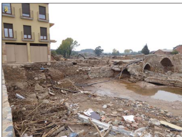
Fig. 23. Vista del tram final del carrer després de l'aiguat.
