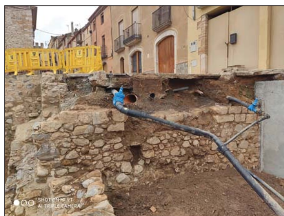
Fig. 24. Vista frontal del portal del Raval, documentat superficialment el 2013.
