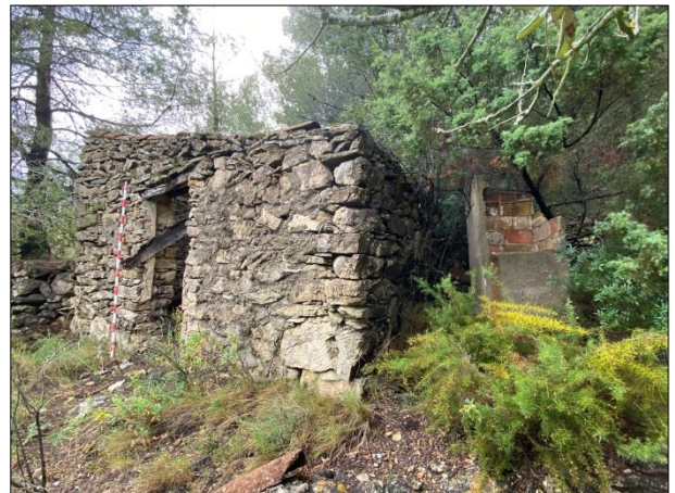
FOTO 4. CIC-03 al camí d'accés a la subestació
