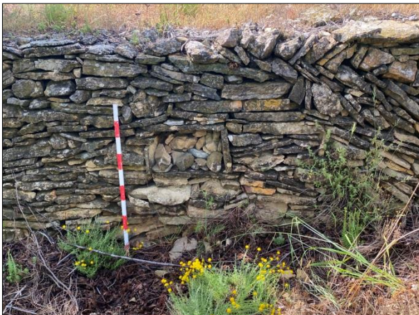
FOTO 3. Marge amb fornícula al camí d'accés a la subestació
