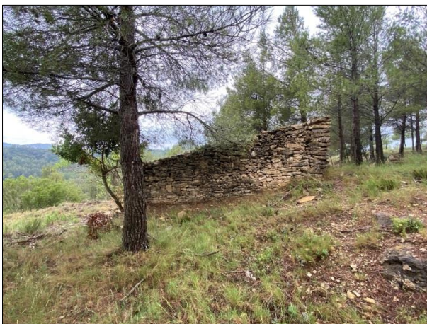
FOTO 11. CIC-06 al camí d'accés a la subestació
