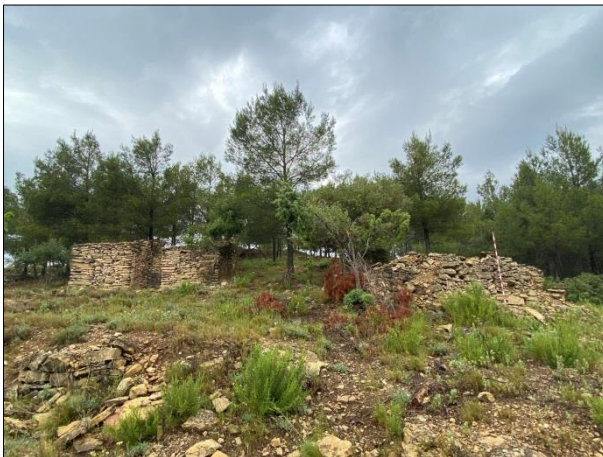
FOTO 9. CIC-06 al camí d'accés a la subestació
