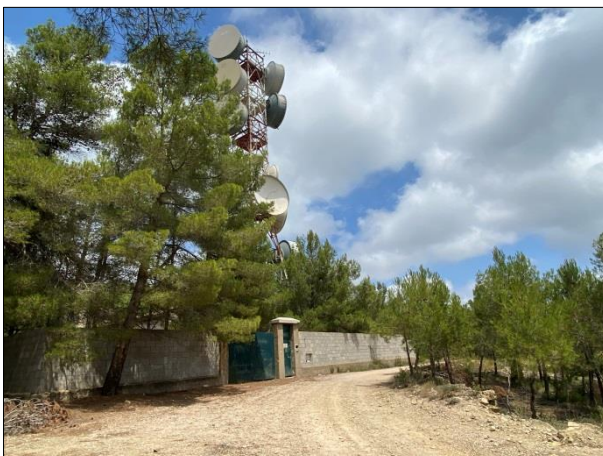
FOTO 5. Complex de repetidors al camí d'accés a la subestació
