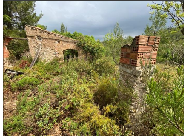
FOTO 14. CIC-08 al camí d'accés a la subestació
