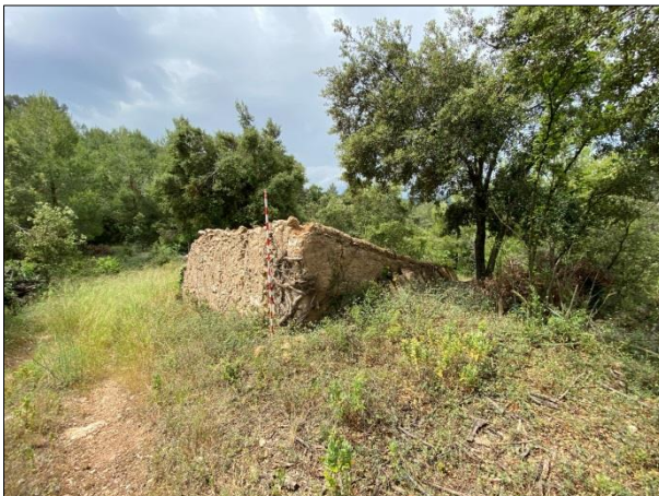
FOTO 15. CIC-09 en la plataforma de la subestació
