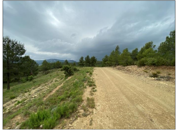
FOTO 8. Camí d'accés a la subestació
