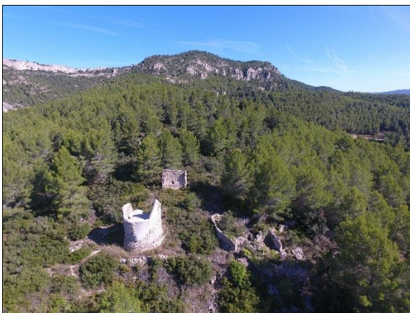
F3. Restes de la Torre de Gavadà (pròpia)
