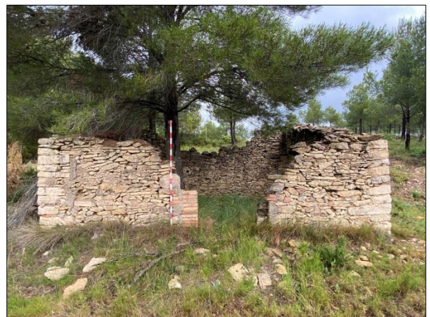
FOTO 12. CIC-07 al camí d'accés a la subestació
