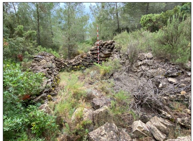
FOTO 6. CIC-04 al camí d'accés a la subestació
