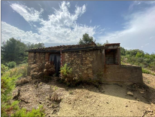
FOTO 1. CIC-02 al camí d'accés a la subestació
