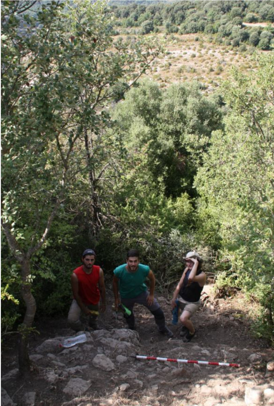
Fig. 49. Detall dels treballs de neteja a l'exterior de la muralla, costat nord.
