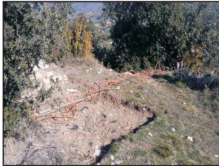
Fotografia 5. Tram del perfil PTE-2
