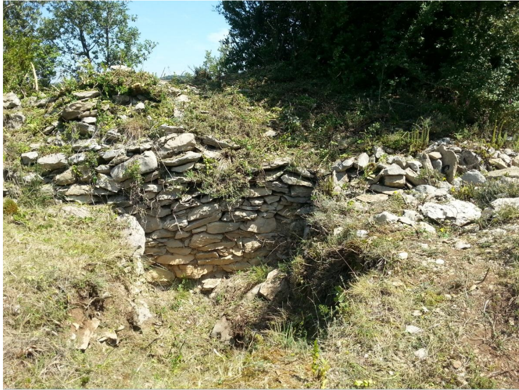
Fig. 45. Treballs de desforestació de la cala 2.
