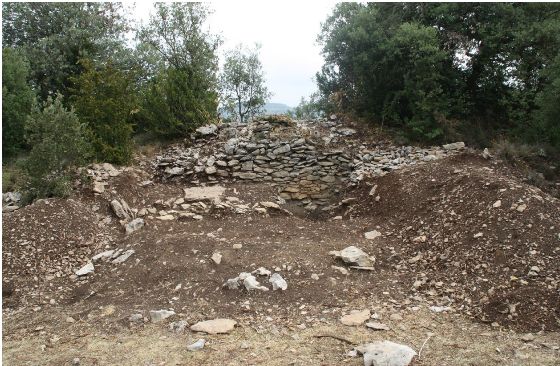
Fig. 63. Imatge final dels treballs previ a la cobertura amb geotèxtil.
