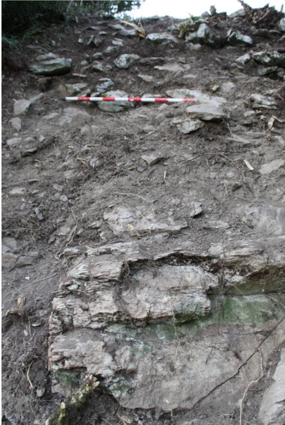
Fig.65. Vista des del camí on s'observa el parament de la muralla per la banda exterior.
