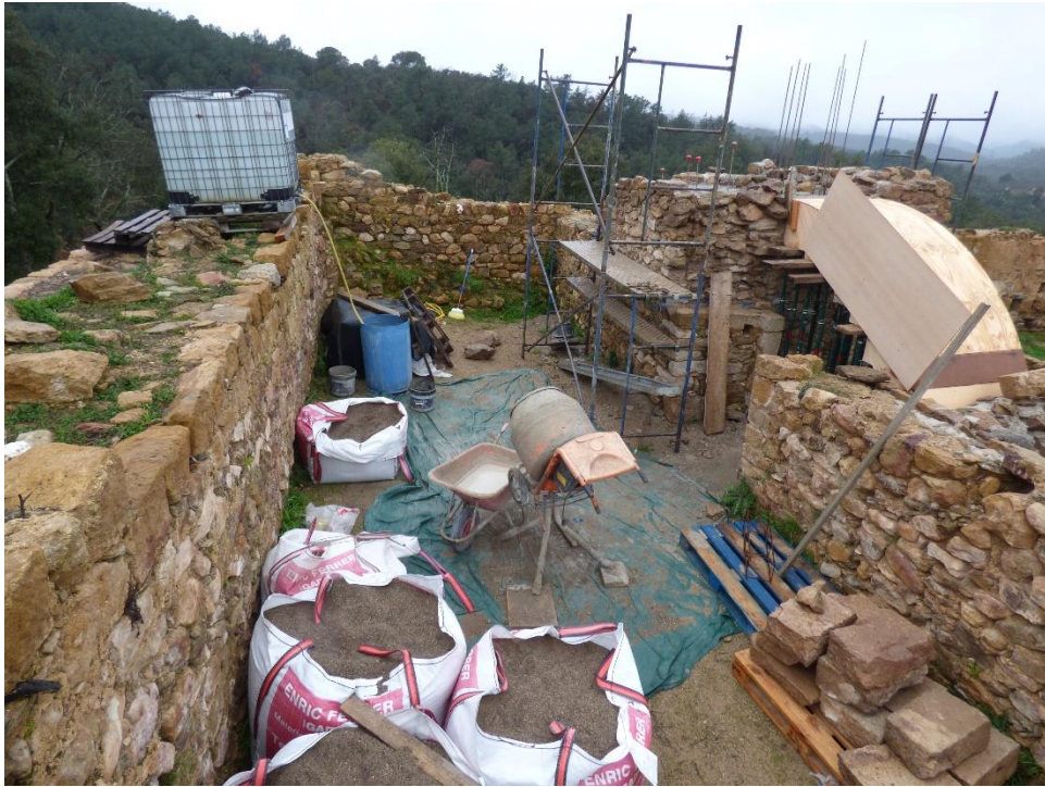
Foto 31: Treballs de reconstrucció de l'escala del pati interior.
