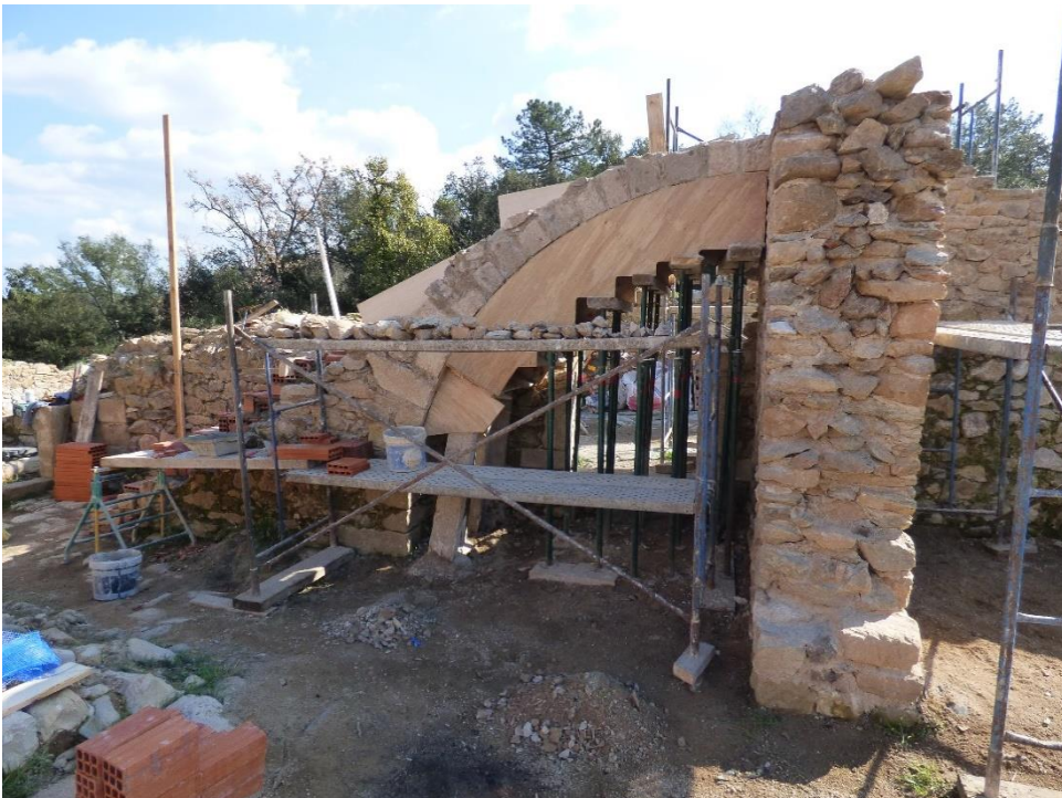
Foto 32: Treballs de reconstrucció de l'escala del pati interior.
