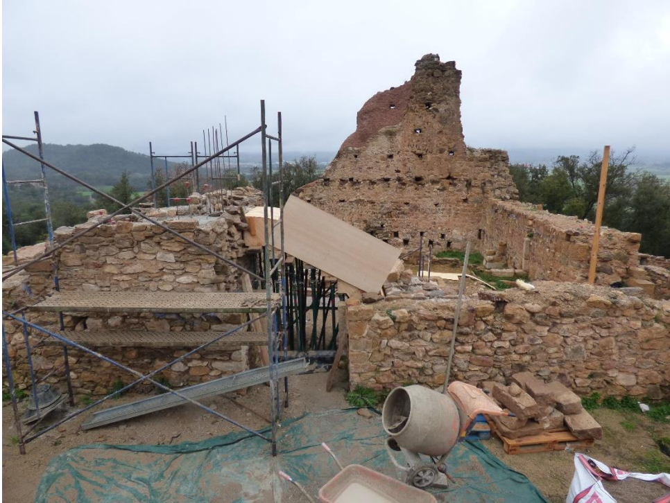
Foto 33: Treballs de reconstrucció de l'escala del pati interior.
