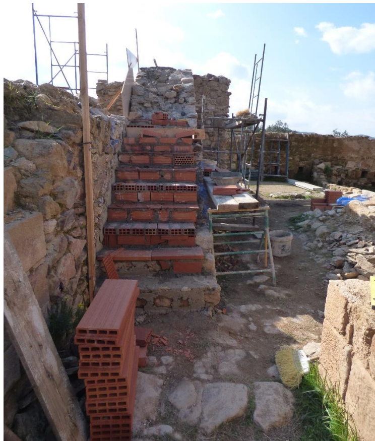
Foto 34: Treballs de reconstrucció de l'escala del pati interior.
