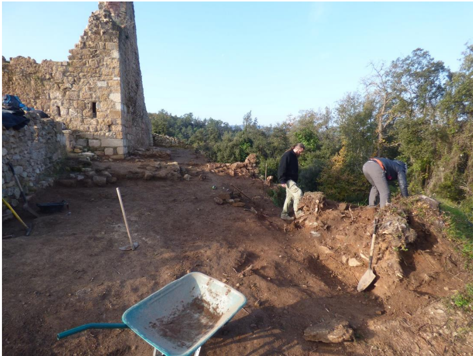
Foto 7: Desenvolupament dels treballs de retirada d'enderrocs i rabasses al sector 8.
