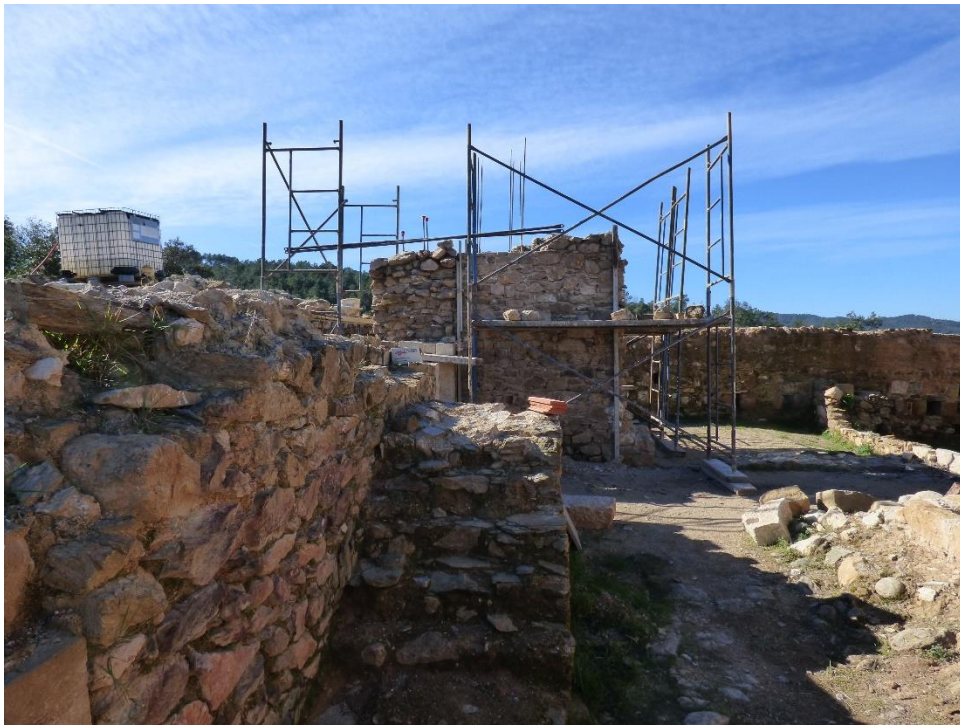
Foto 29: Vista del mur M-9 en procés de reconstrucció.
