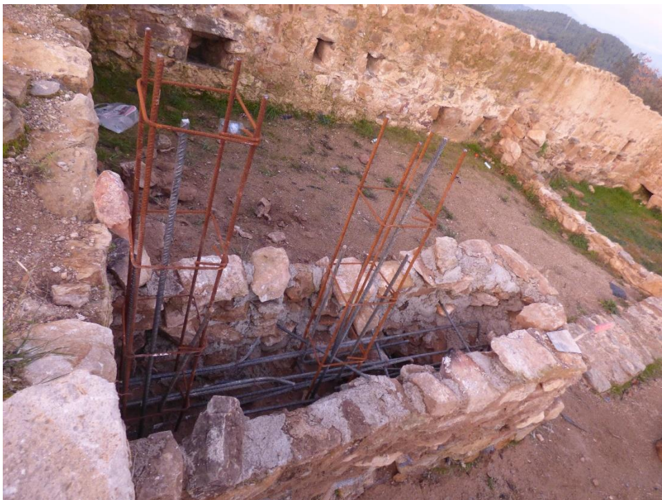
Foto 28: Detall dels treballs de reconstrucció del mur M-9 que fa de contrafort de l'escala del pati interior.
