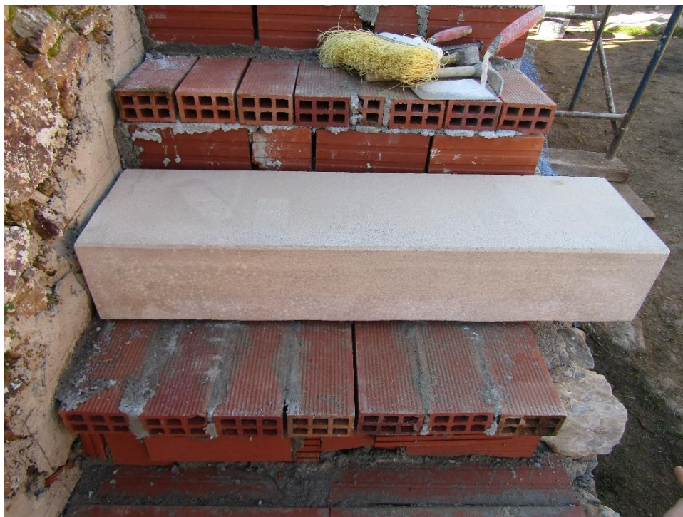
Foto 36: Detall del procés de construcció de l'escala del pati interior.
