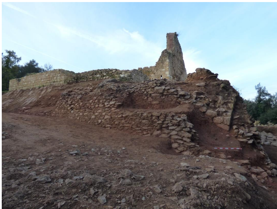
Foto 23: Detall de la cantonada nord-est çun cop finalitzats els treballs de neteja.
