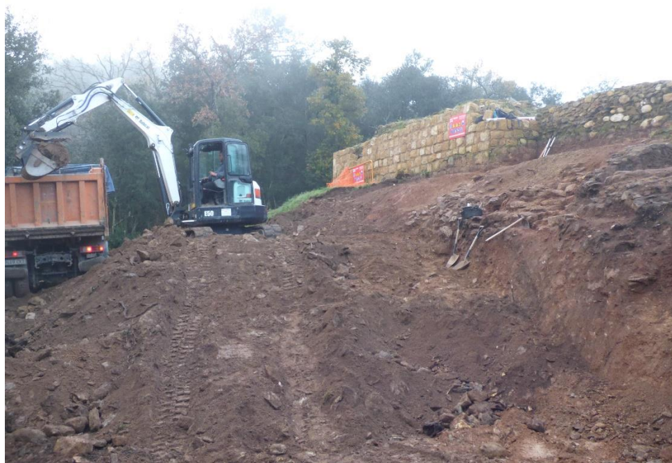
Foto 10: Treballs de retirada de la terrera acumulada a l'ala est del fossat.
