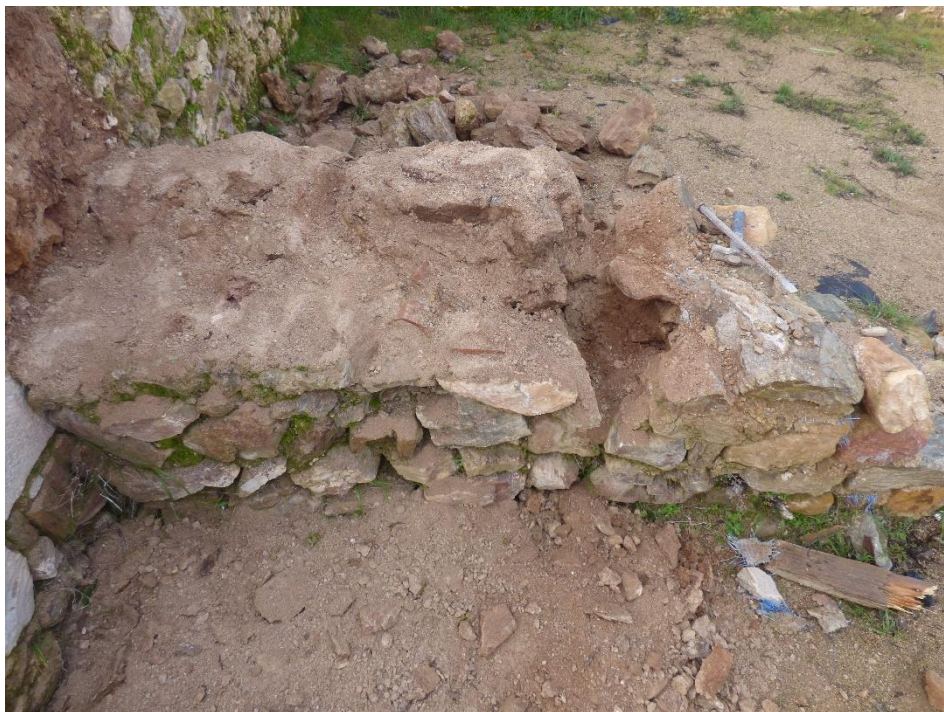
Foto 25: Detall dels treballs de neteja i desmuntat del mur M-9 per iniciar els treballs de reconstrucció.
