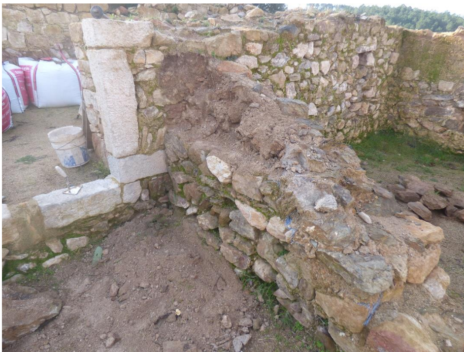
Foto 26: Detall del mur M-9 del pati interior del castell. Desmuntat parcialment per poder-lo reconstruir.
