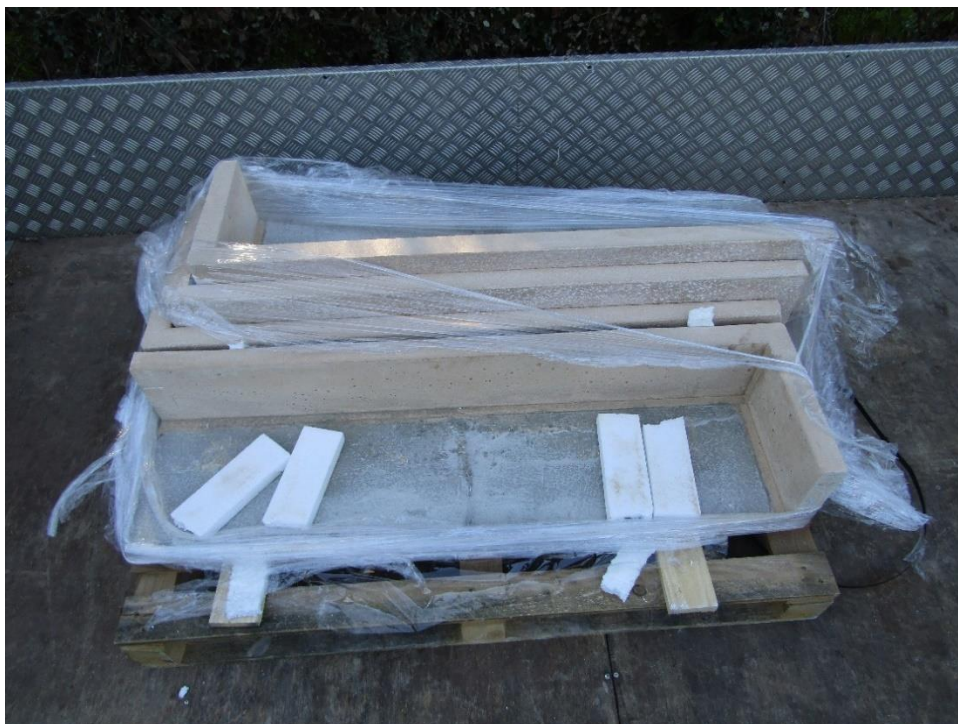
Foto 35: Detall dels graons prefabricats a mida per l'escala interior.
