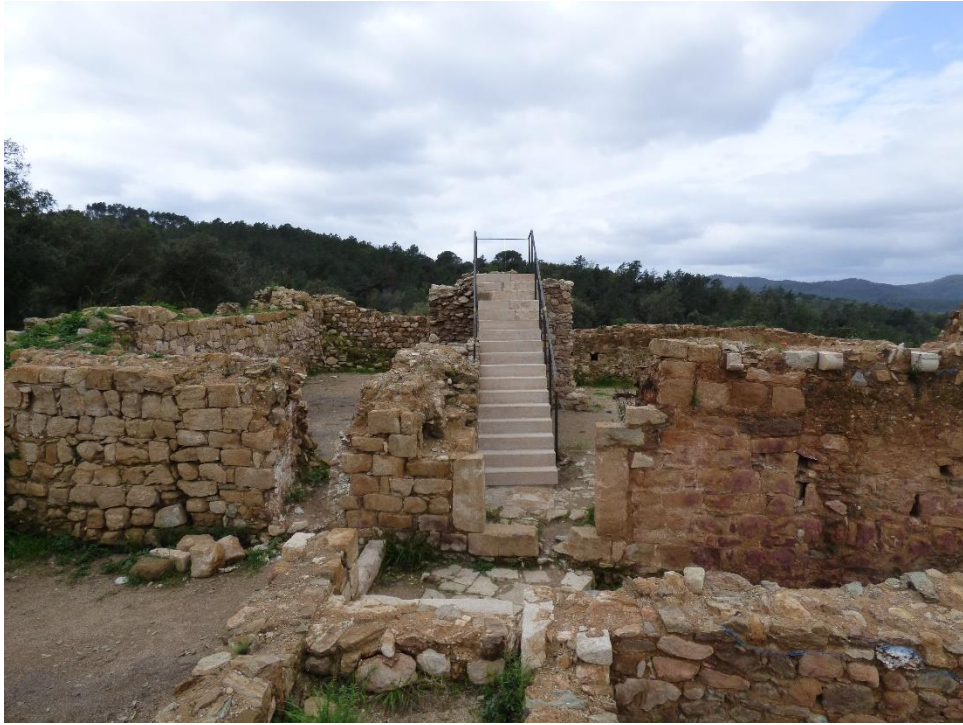
Foto 39: Vista general de l'escala un cop finalitzada.
