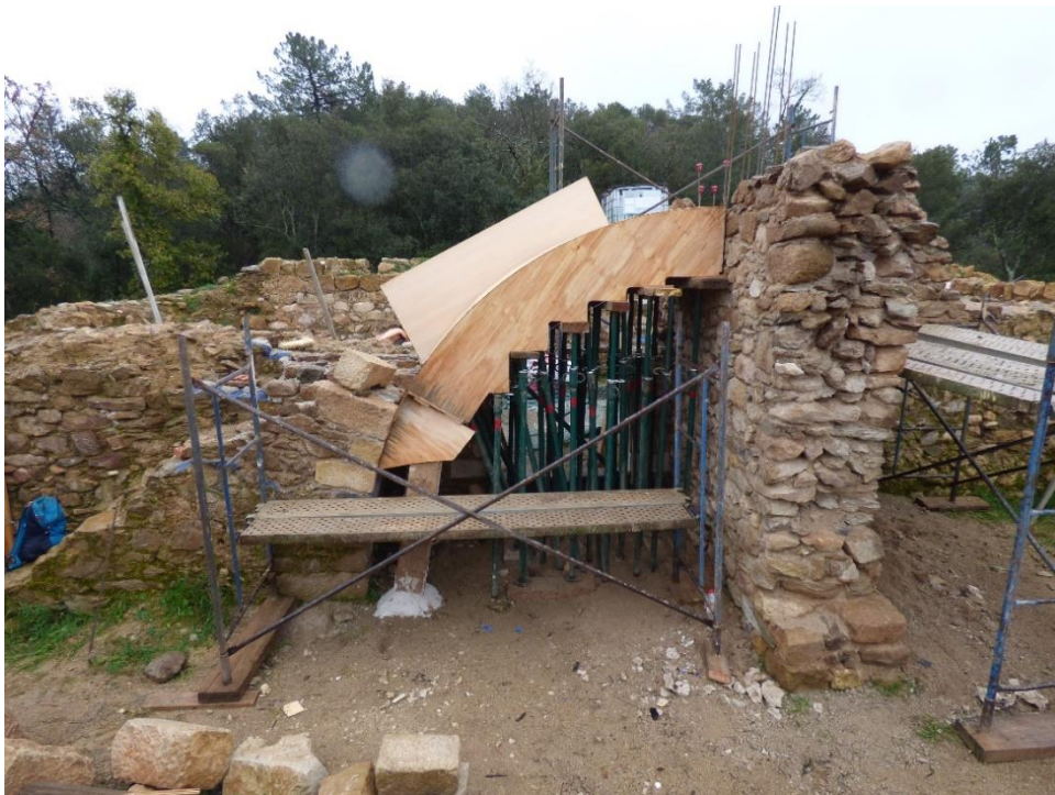
Foto 30: Detall dels treballs de reconstrucció de l'escala del pati interior.
