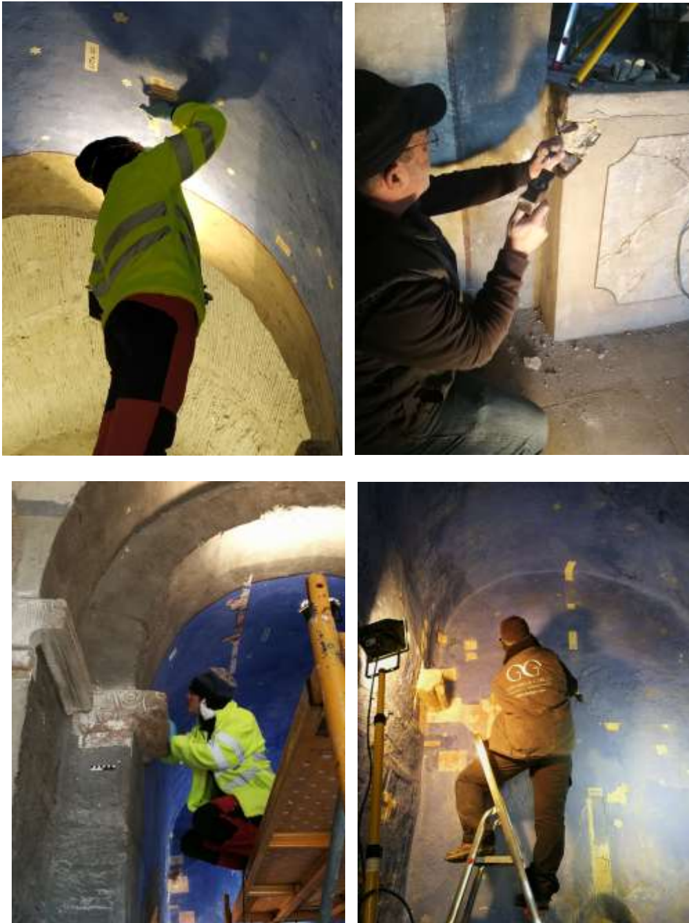
Execució de les cales pictòriques i estructurals
