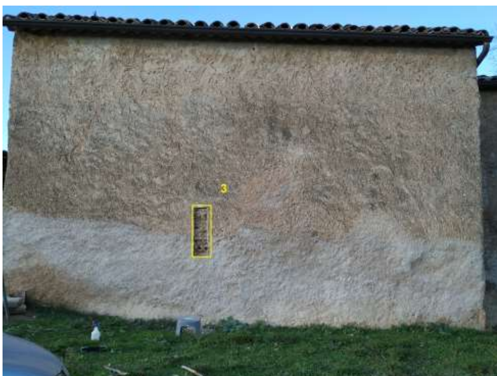
Ubicació de les cales exteriors
