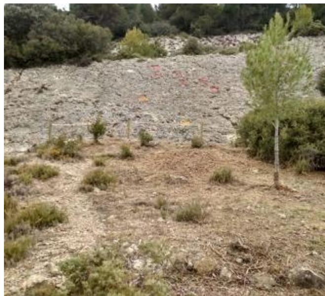
Barana instal·lada al sector est
