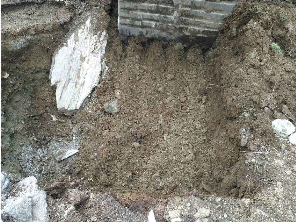
Foto 61: Excavació a màquina de sondeig al sector O
