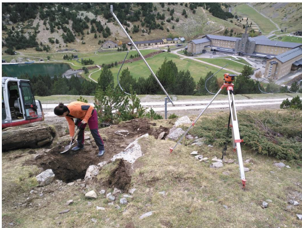
Foto 21: Ampliació del primer sondeig
