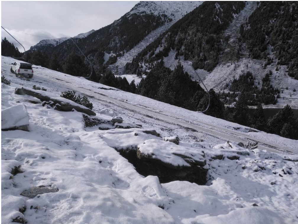
Foto 65: Final zona excavada
