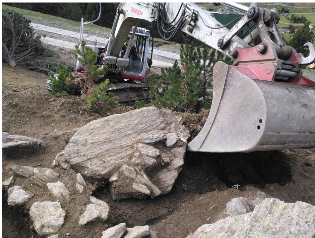
Foto 43: Extracció d'una tercera llosa
