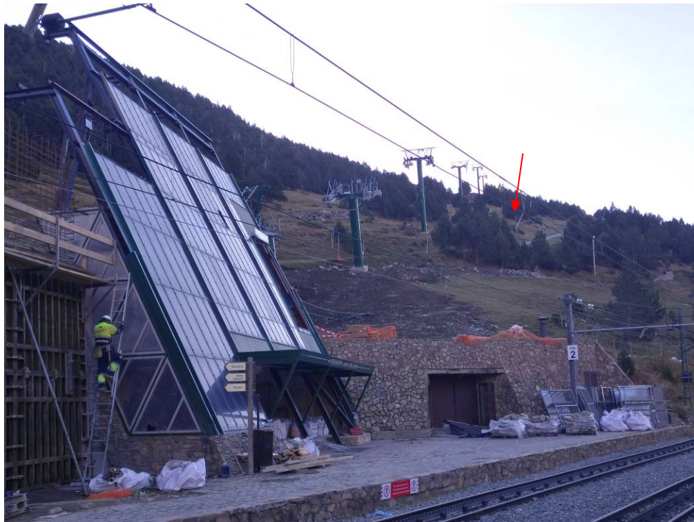
Foto 1: Ubicació de la intervenció des de l'estació del cremallera
