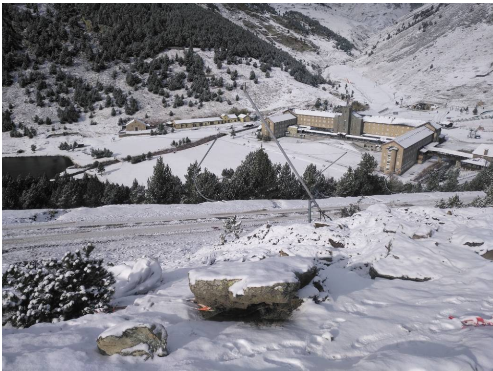
Foto 66: Final zona excavada
