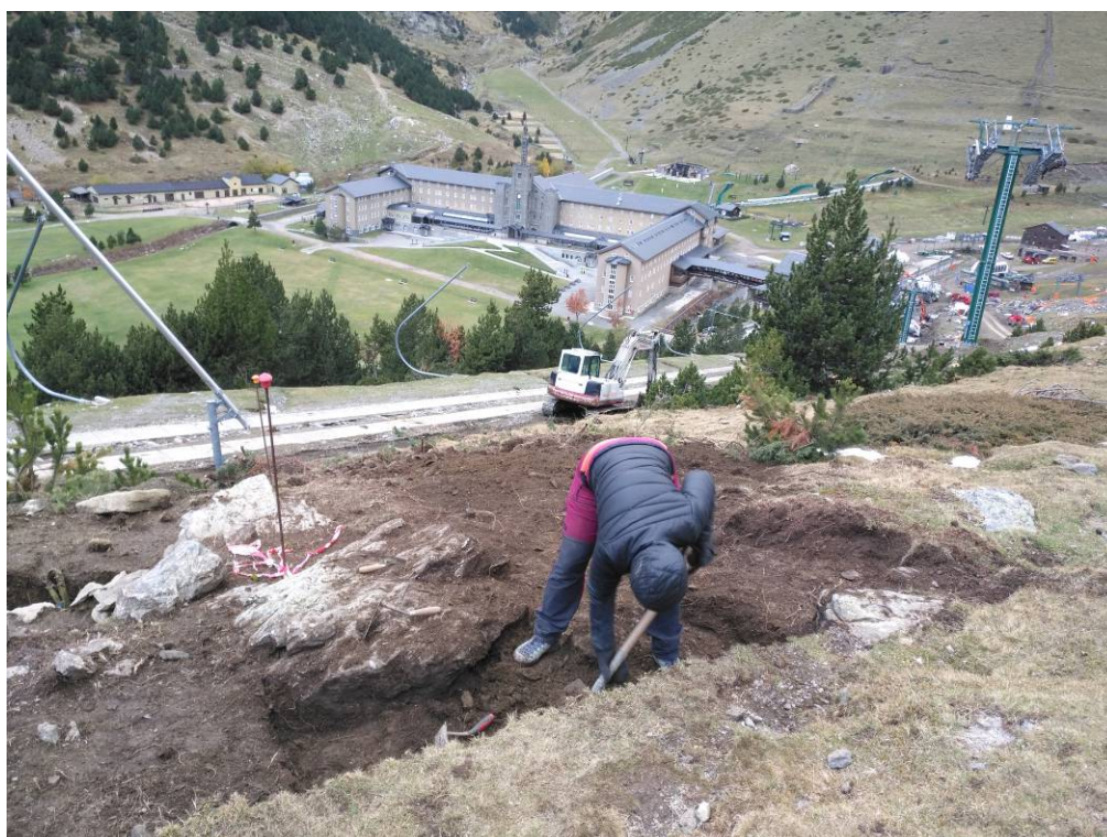
Foto 52: Excavació del tercer sondeig
