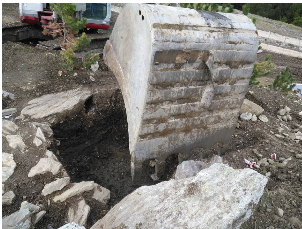
Foto 60: Excavació a màquina de sondeig al sector O
