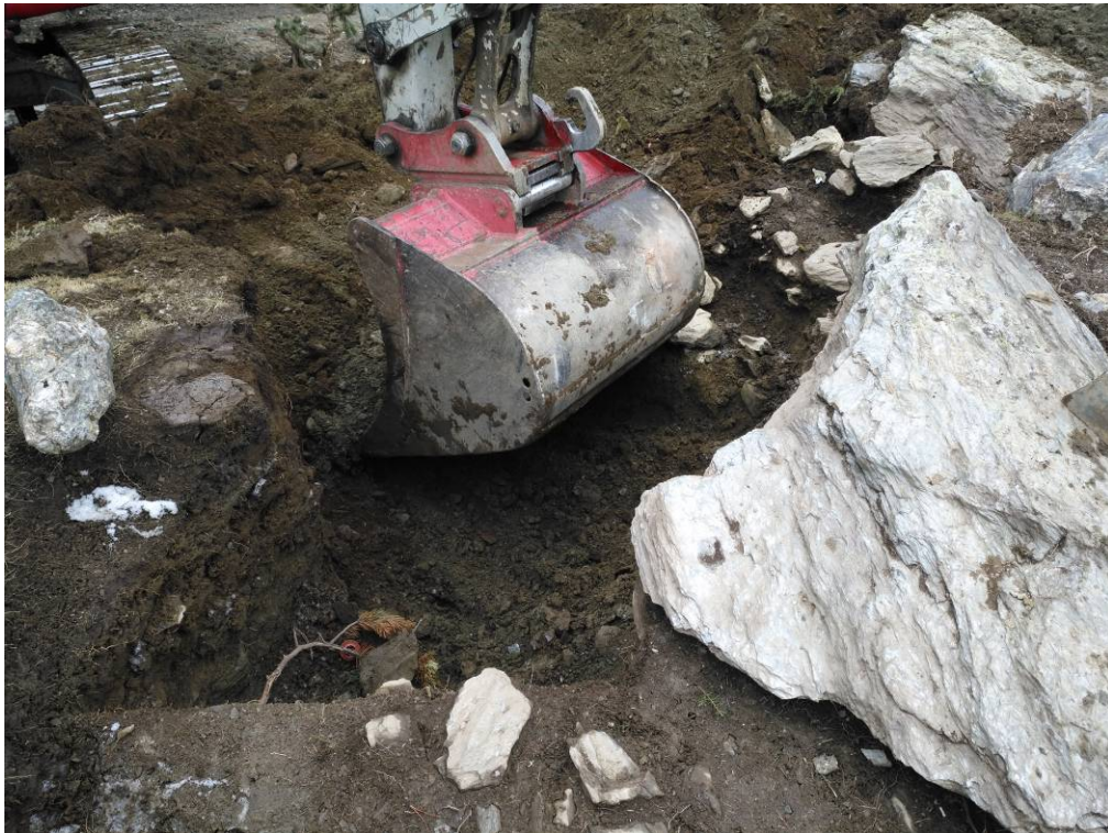
Foto 63: Excavació a màquina de sondeig al sector S
