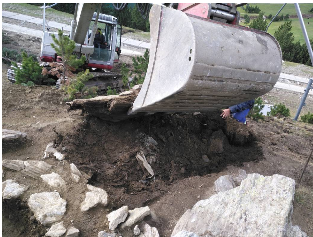
Foto 44: Extracció d'una tercera llosa
