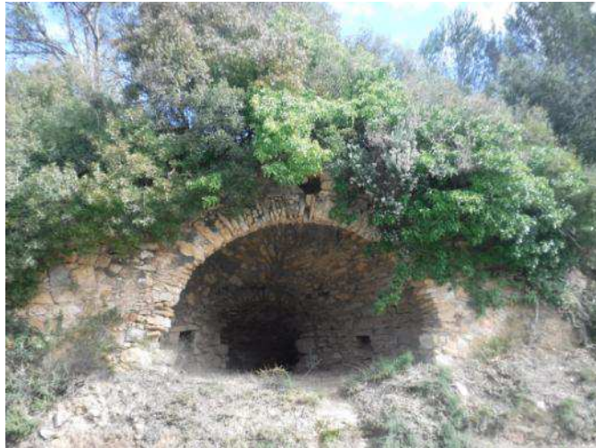
20. Vista general del forn de calç, des de l'oest.
