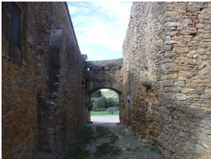
17. Corredor d'accés, des de l'est, amb el portal al fons. A l'esquerra, la paret nord de l'habitatge 3, amb la fase antiga (sobresortint) a la que se superposa el mur posterior del mas.
