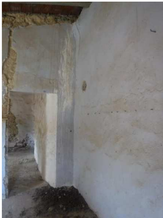
14. Interior de l'habitatge 2. Mur de la torre del costat del portal (al fons) diferenciant-se dels afegits posteriors pel seu major gruix
