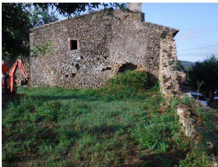
16. Façana nord del mas central, que reaprofitava parcialment un dels murs transversals a la muralla oest, que apareix a la dreta de la imatge. Imatge de l'any 2018.
