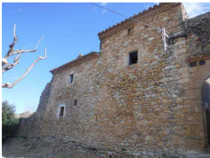
11. Costat oest de l'habitatge 2 reaprofitant la muralla oest. A la dreta, el portal.
