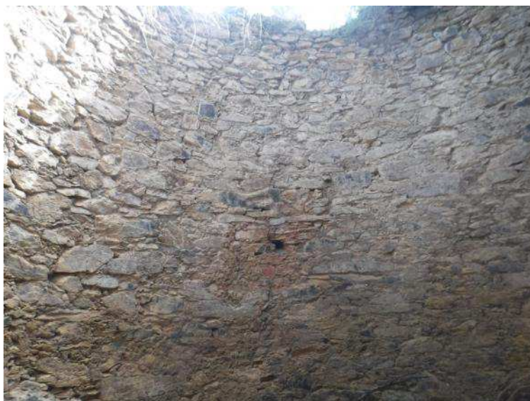
23. Volta de l'interior del forn.
