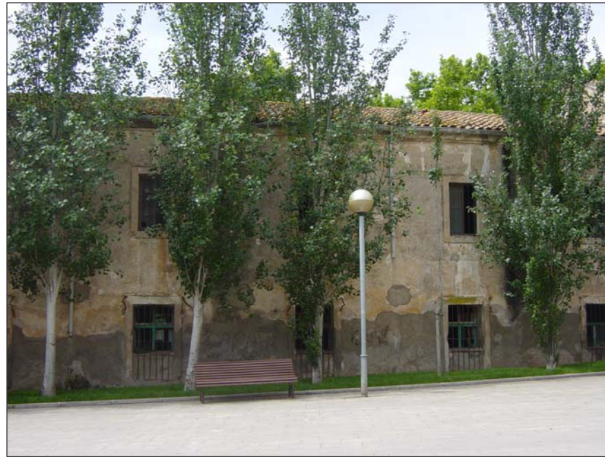
Façana est de la caserna
