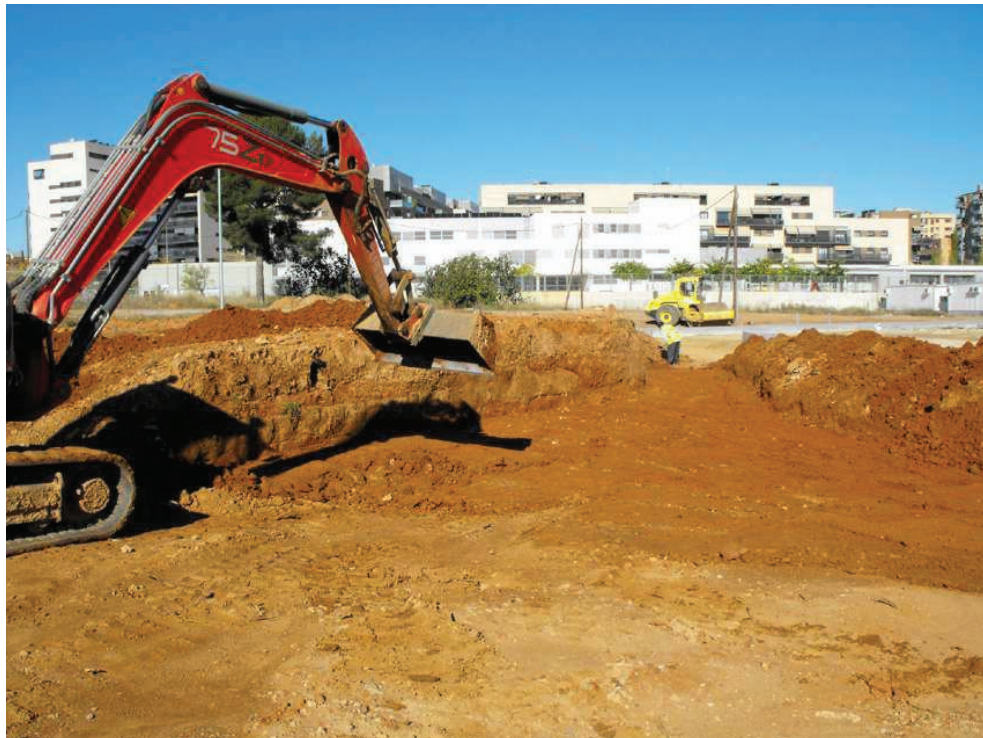
POLÍGON II CAN LLONG - CARRER VENÈCIA (Sabadell, Vallès Occ.). - Fotografia de la màquina retroexcavadora netejant la superfície sota control arqueològic, des del SE.
