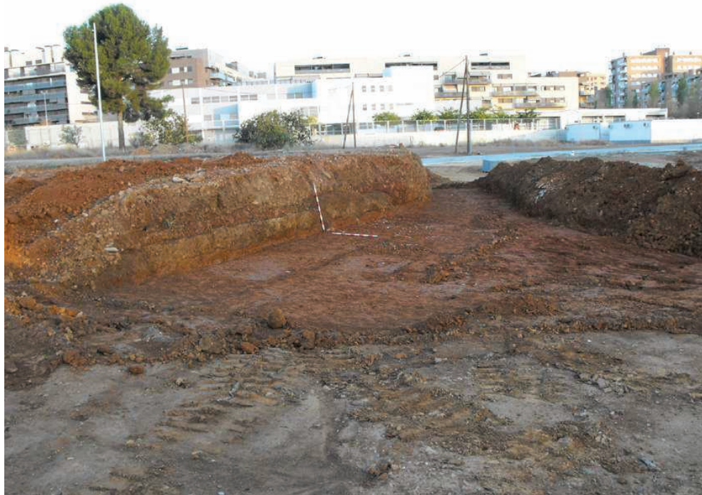
POLÍGON II CAN LLONG - CARRER VENÈCIA (Sabadell, Vallès Occ.) .- Una altra vista de la zona afectada des del sudoest. S'observa el tall del marge i el terreny natural en superfície.
