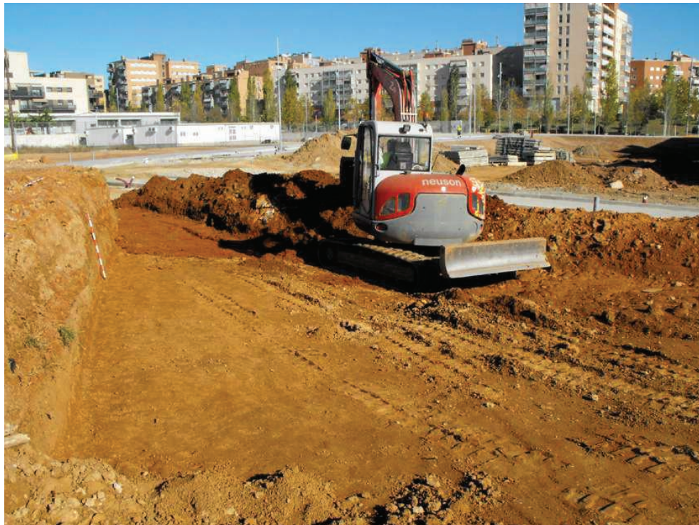
POLÍGON II CAN LLONG - CARRER VENÈCIA (Sabadell, Vallès Occ.). - Imatge general de les tasques de neteja de la superfície afectada pels rebaixos, des del sud
