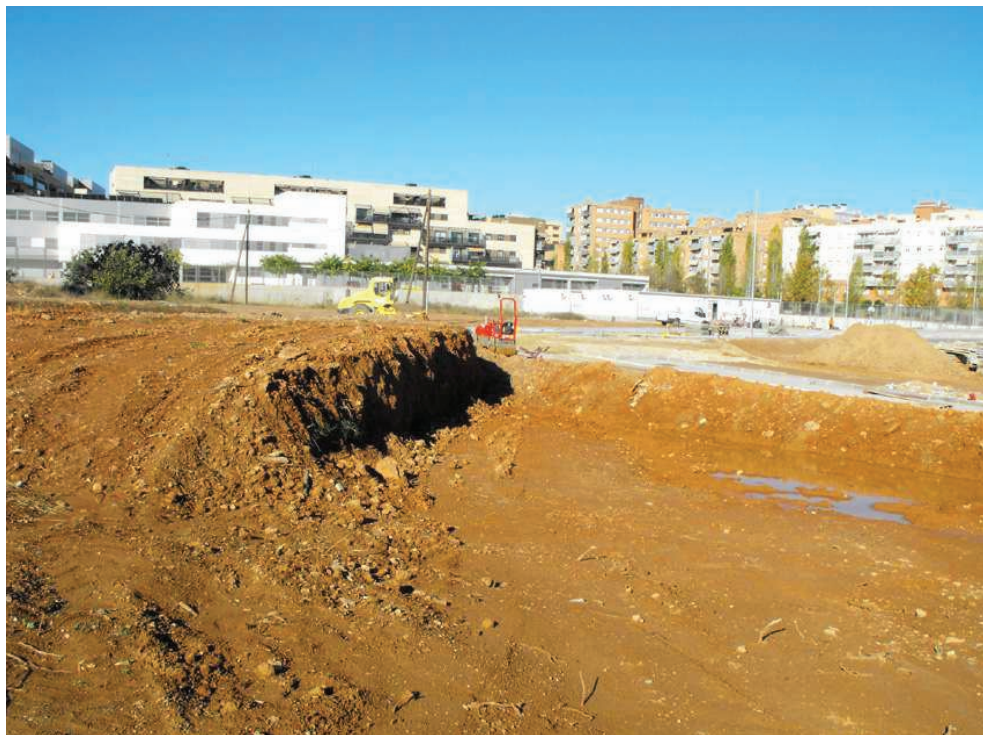
POLÍGON II CAN LLONG - CARRER VENÈCIA (Sabadell, Vallès Occ.) .- Imatge inicial del tall del marge, i la superfície afectada pels moviments de terres, des del sudoest.
