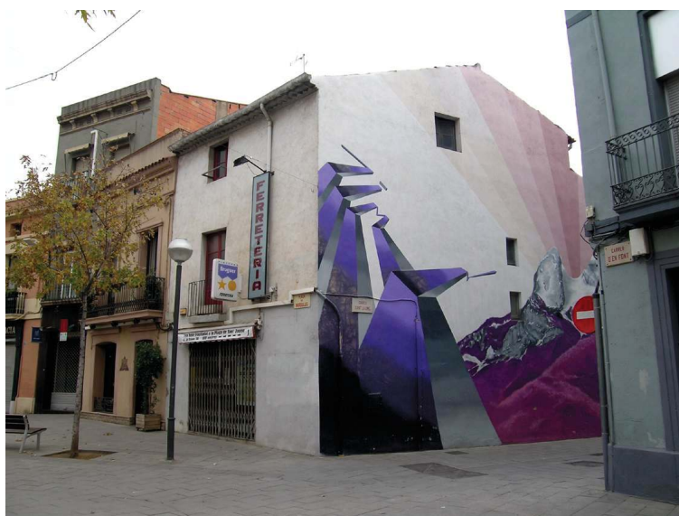
PLAÇA MARQUILLES, 1 (Sabadell, Vallès Occ.) - Vista de l'edifici de la Plaça Marquilles, 1 abans del seu enderroc des del costat del carrer Sant Jaume.
