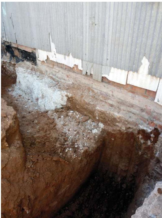
PLAÇA MARQUILLES, 1 (Sabadell, Vallès Occ.) .- Detall de la Rasa 5 on es pot veure les argiles vermelles del terreny natural que apareixen per sota el paviment de la casa. No es va localitzar cap resta arqueològica.
