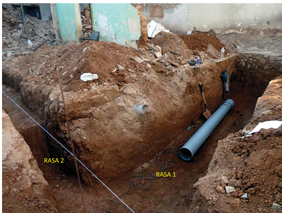
PLAÇA MARQUILLES, 1 (Sabadell, Vallès Occ.) .- Vista de la Rasa 1 en el seu punt d'unió amb la Rasa 2, situada al cantó nord del solar, seguint la línia de façana del carrer Sant Jaume. Sense presència de restes arqueològiques.
