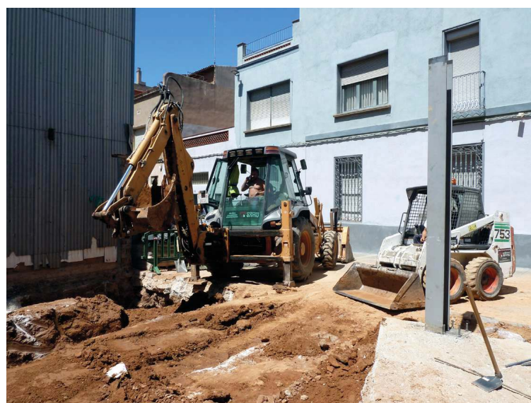
PLAÇA MARQUILLES, 1 (Sabadell, Vallès Occ.) - Vista del solar durant els treballs de control arqueològic i obertura de rases amb màquina retroexcavadora.
