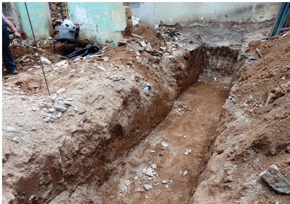
PLAÇA MARQUILLES, 1 (Sabadell, Vallès Occ.). - Vista de la Rasa 1, feta al centre del solar amb una direcció aproximada nord – sud. Fa 1,30m d'amplada i 1 – 1,20m de fondària. Sense presència de restes arqueològiques.
