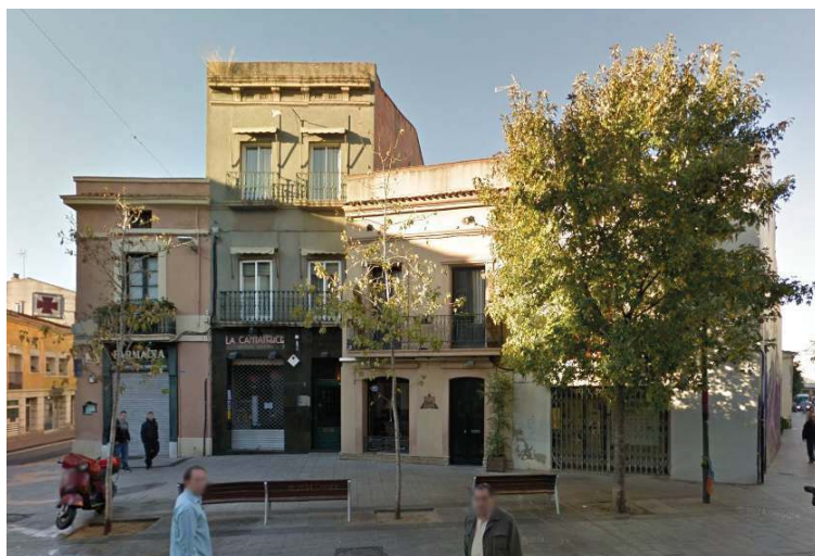
PLAÇA MARQUILLES, 1 (Sabadell, Vallès Occ.) - Vista de situació del solar a la Plaça Marquilles abans d'enderrocar- ne l'edifici.
