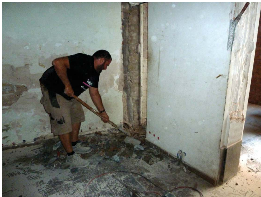
C/ SALUT, 24 (Sabadell, Vallès Occ.). -Vista dels treballs d'obertura de la cala, en el moment de la retirada del paviment de rajoles superior.
