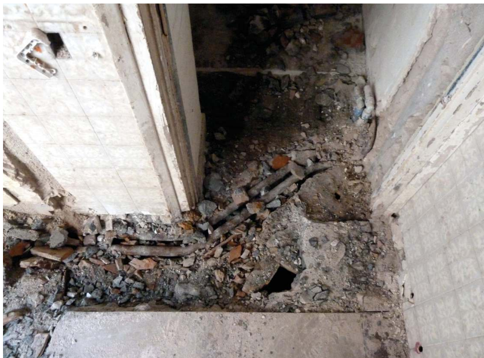
C/ SALUT, 24 (Sabadell, Vallès Occ.). -Vista de la cala un cop retirat el paviment de rajoles que ho cobria. Es poden veure les canalitzacions i serveis que hi passen.
