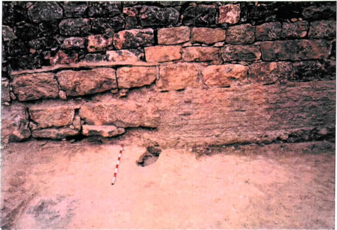
Fot. 3- Detall de l'excavació 93-N-5000.
