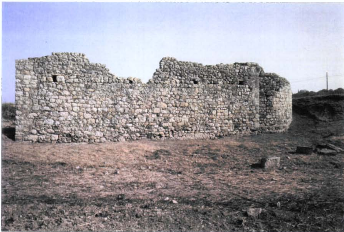
Fotografia 3.- Vista des del Sud de l'exterior de l'església de Santa Margarida. S'observa el parament de la nau lateral i de l'absis pertanyent a la Cinquena Fase (núm. arxiu: 101-7).
