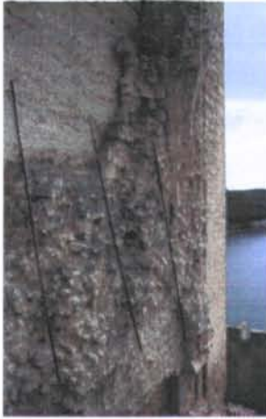
UE 81 i UE 82. Arc i mur de suport
