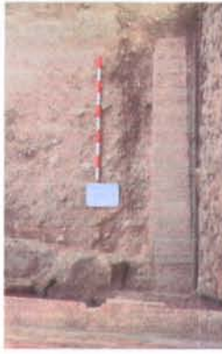
UE 88 i UE 89. Canalització i rasa de fonamentació
