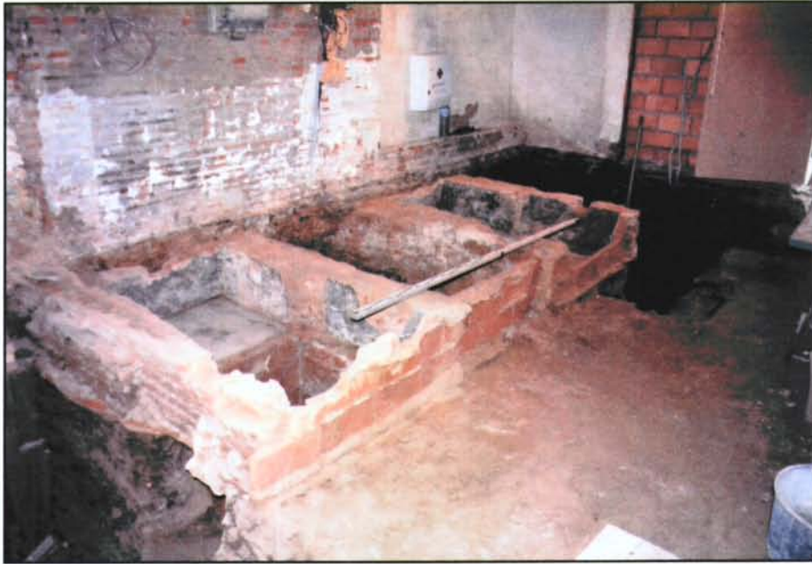
FOTO 3: Vista general dels dipòsits moderns UE 79, 81 i 83.
