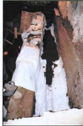
Protecció amb geotèxtil
