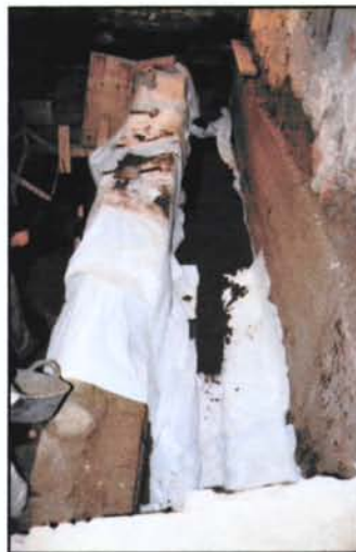
Protecció amb geotèxtil
