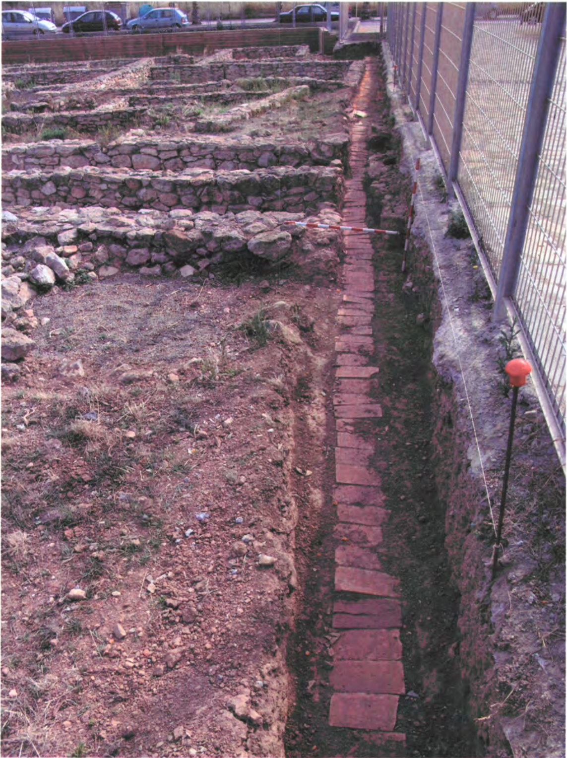
Fig. 14. Recorregut de la canonada elèctrica (02014) pel sector 5 i les cases 1 i 3.
