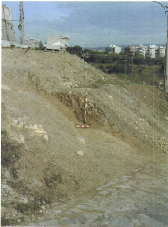
Figura 10. Rasa manual. Vista lateral un cop finalitzats els treballs
