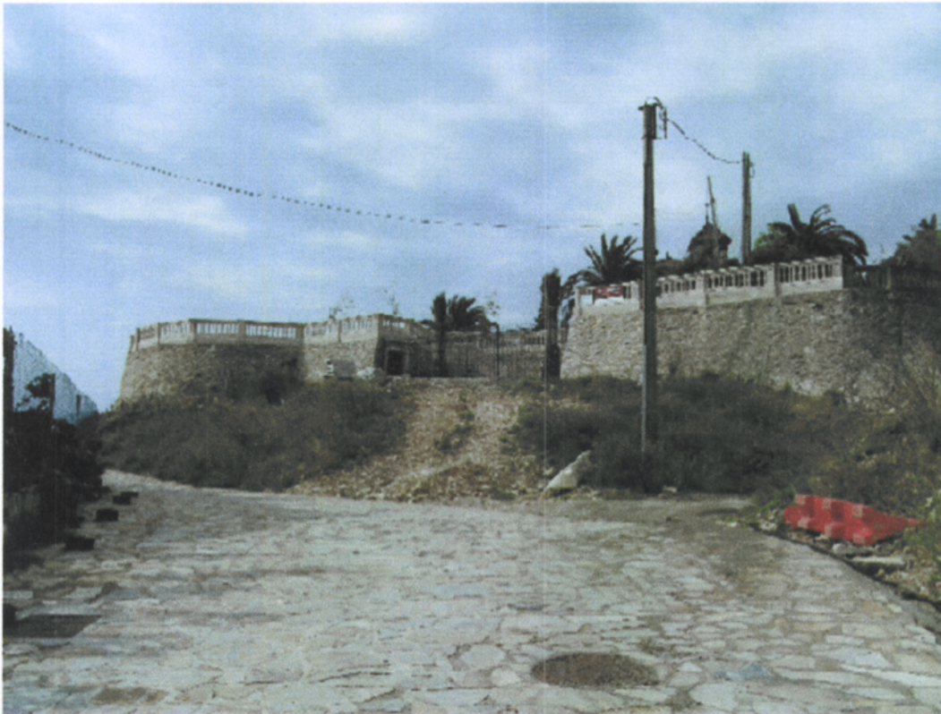
Figura 8. Vista general de la zona d'accès al Xalet del Nin. Prèvia a l'inici dels treballs
