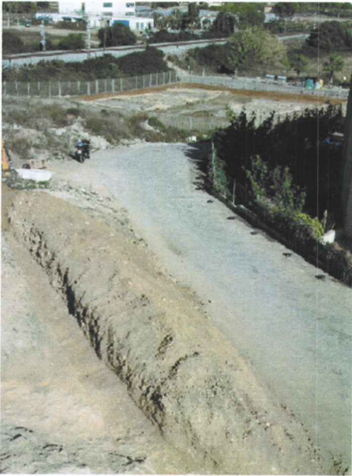
Figura 12. Rasa efectuada amb màquina excadora. Situació
