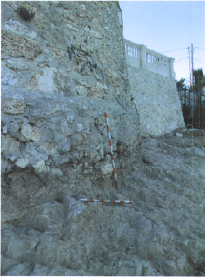
Figura 14. Extrem oest de la zona excavada. Vista general de la roca i disposició de la construcció moderna
