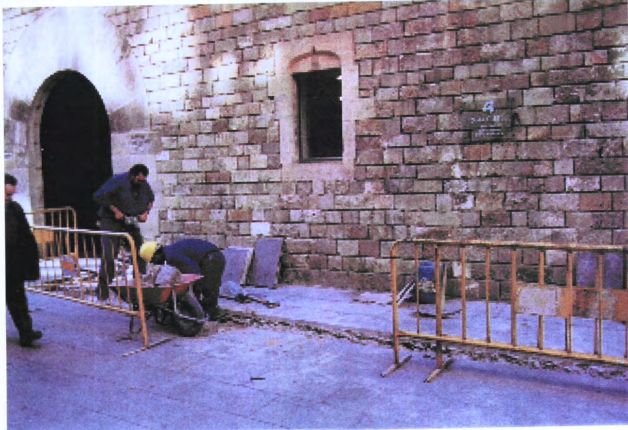
FOTO 5 Treballs d'obertura de la rasa 1 ( U.E. 1000)
