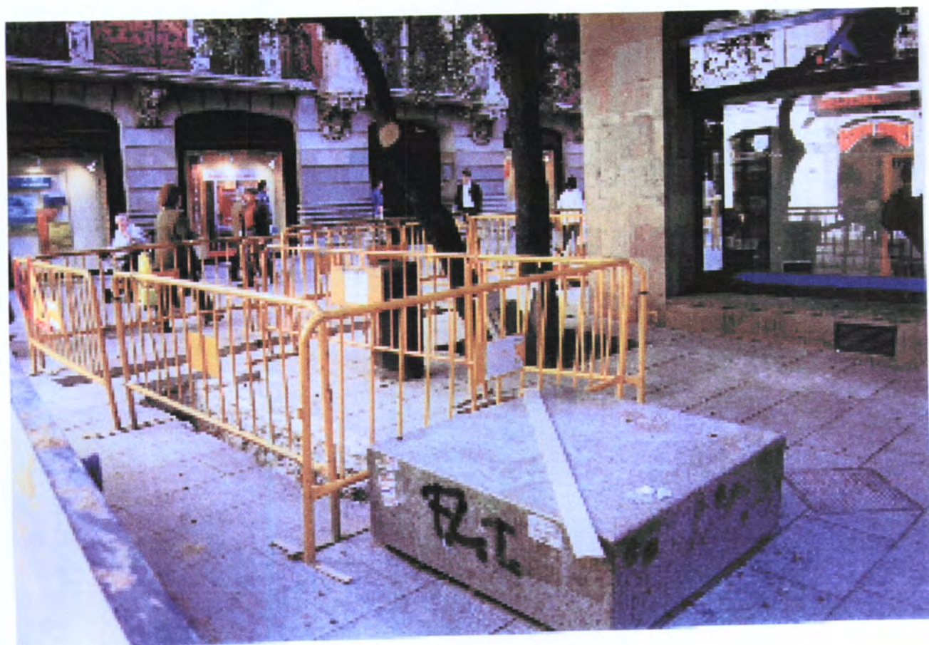
FOTO 6 Vista de la intervenció amb la cala de prova 6 ( U.E. 600 )
