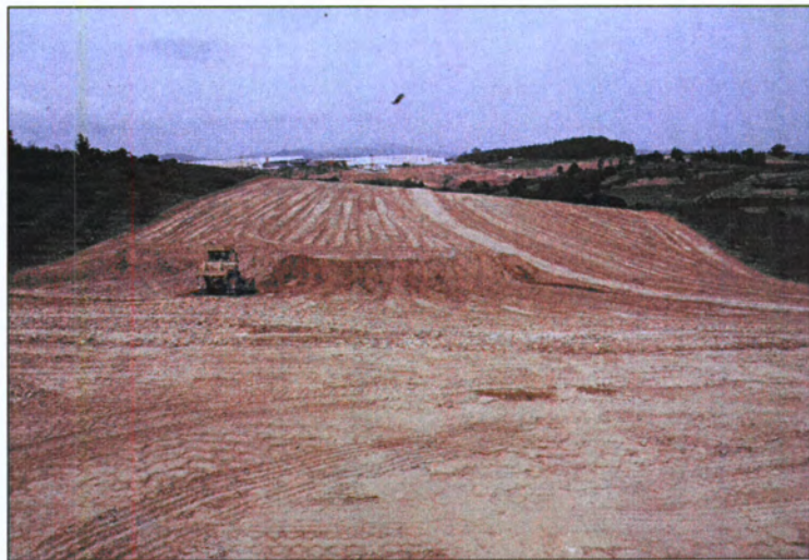
Vista parcial del tram un cop retirades les terres vegetals
