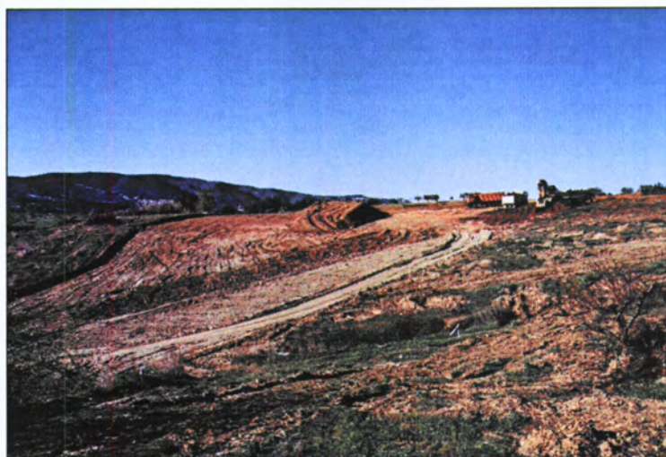
Vista parcial del tram sud un cop iniciades les obres.
