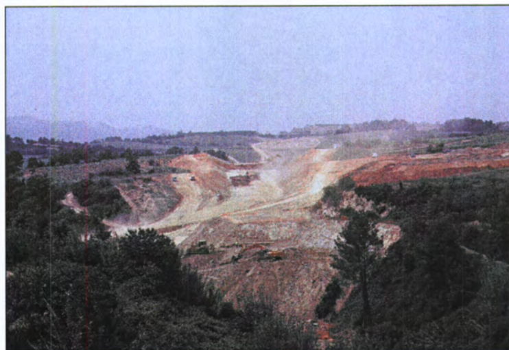
Vista general del dector sud un cop retirades les terres vegetals
