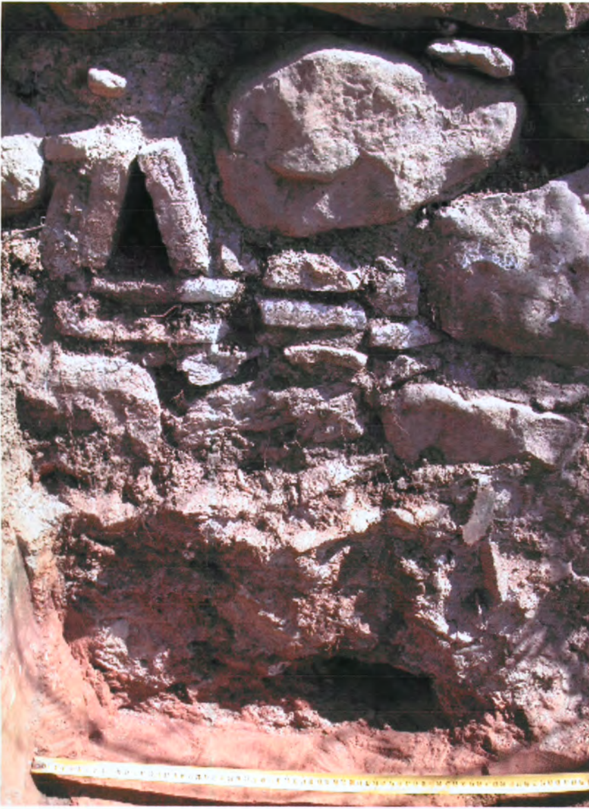
Fig. 18. Cala 3. Detall dels fonaments del mur 1.
