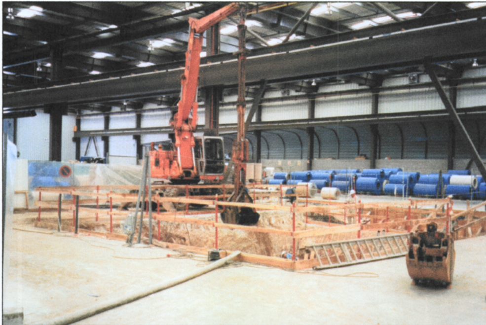
Imatge de les obres dins la nau industrial
