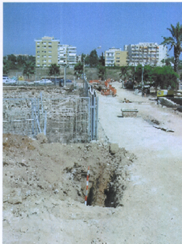
Figura 16. Vista general del sondeig 3
