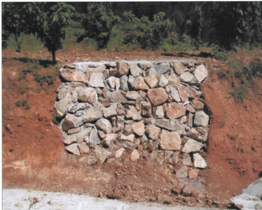
Estructura farcida amb pedra de mitjan tamany
